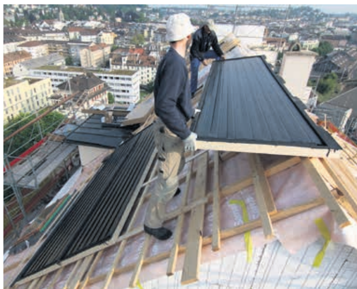
Hoch über den Dächern von Luzern: Montage einer Solaranlage an der Sternegg 12.
