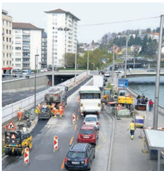
Zwischen dem Natur-Museum und der Geissmattbrücke wird zurzeit ein Veloweg gebaut.
