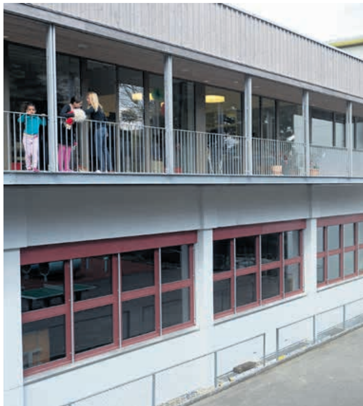
Da es auf dem Gelände der Schulanlage keinen Platz hatte, wurde auf der Turnhalle ein Neubau errichtet.
