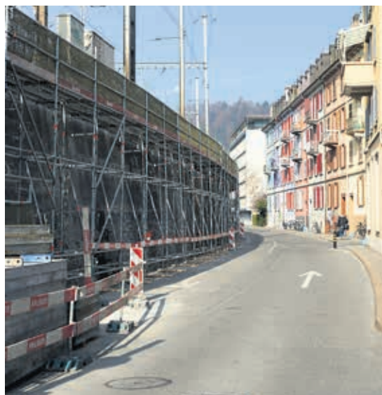
Maximal 2 Meter hoch sind die Lärmschutzwände am Bahndamm zwischen Basel- und Dammstrasse.
