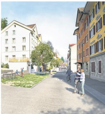
Anfang April 2023 haben die Bauarbeiten in der Lindenstrasse begonnen. Sie dauern voraussichtlich 15 Monate. Um eine flexibel nutzbare Fläche zu erhalten, wird das Strassenniveau auf das Niveau des Trottoirs angehoben. Die Fahrbahnbreite wird auf vier Meter reduziert, damit ein drei Meter breiter Gehbereich realisiert werden kann. Im westlichen Bereich der Lindenstrasse gibt's
