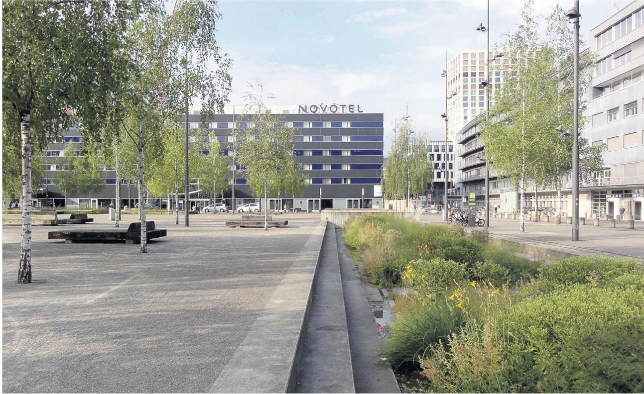
Turbinenplatz in der Stadt Zürich: Hier wird das Schwammstadt-Prinzip umgesetzt. Regenwasser vom ganzen Platz wird in das begrünte Tiefbeet geleitet. Dort wird es gespeichert und trägt später über die Verdunstung zur Kühlung bei. Das erhöht die Aufenthaltsqualität.
