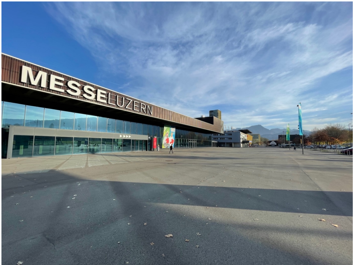
Abbildung 14: Eingang und Vorzone der Messe Luzern
