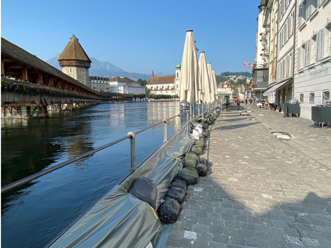
Hochwasser Luzern Juli 2021
