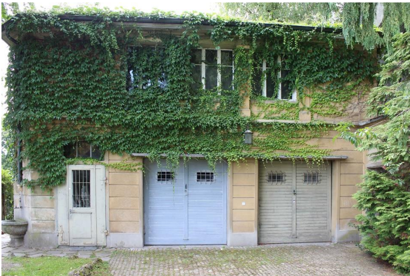
Fassade der Remise. Die beiden Garagen sollen nach der Sanierung den Mieterinnen und Mietern der Wohnungen zur Verfügung stehen. Das Obergeschoss kann für eine nicht gewerbliche Nutzung angemietet werden.
