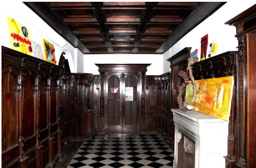
Eingangshalle mit Blick in Richtung Osten. Die Wandtäfer mit geschnitztem Dekor sowie die Türblätter und Türeinfassungen stammen teilweise aus dem 17. Jahrhundert und wurden zweitverwendet
