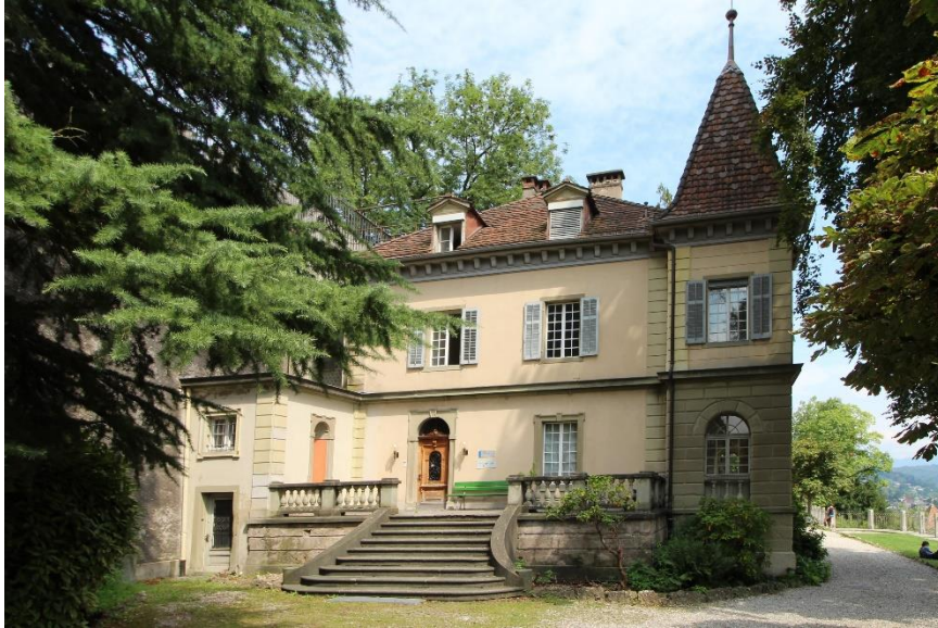
Haupteingangstür auf der Westseite der Villa (B+A Abb.3)
