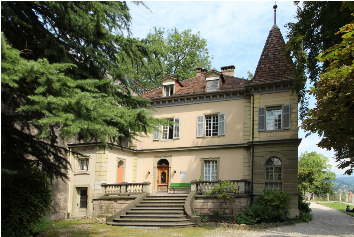
Abb. 3: Westfassade mit Terrassenvorbau und Haupteingang
