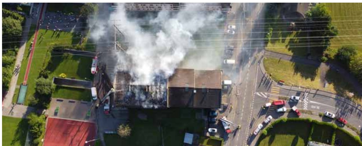
27. Juni 2020: Brand Dachstock Luzernerstrasse
