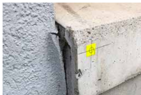
Überwachung des Fundaments an der Fassade
