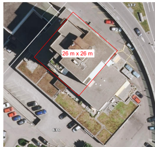
Abb. 5: Luftbild Reusszopf-Hochhaus mit eingezeichnetem Hochhausstandort
