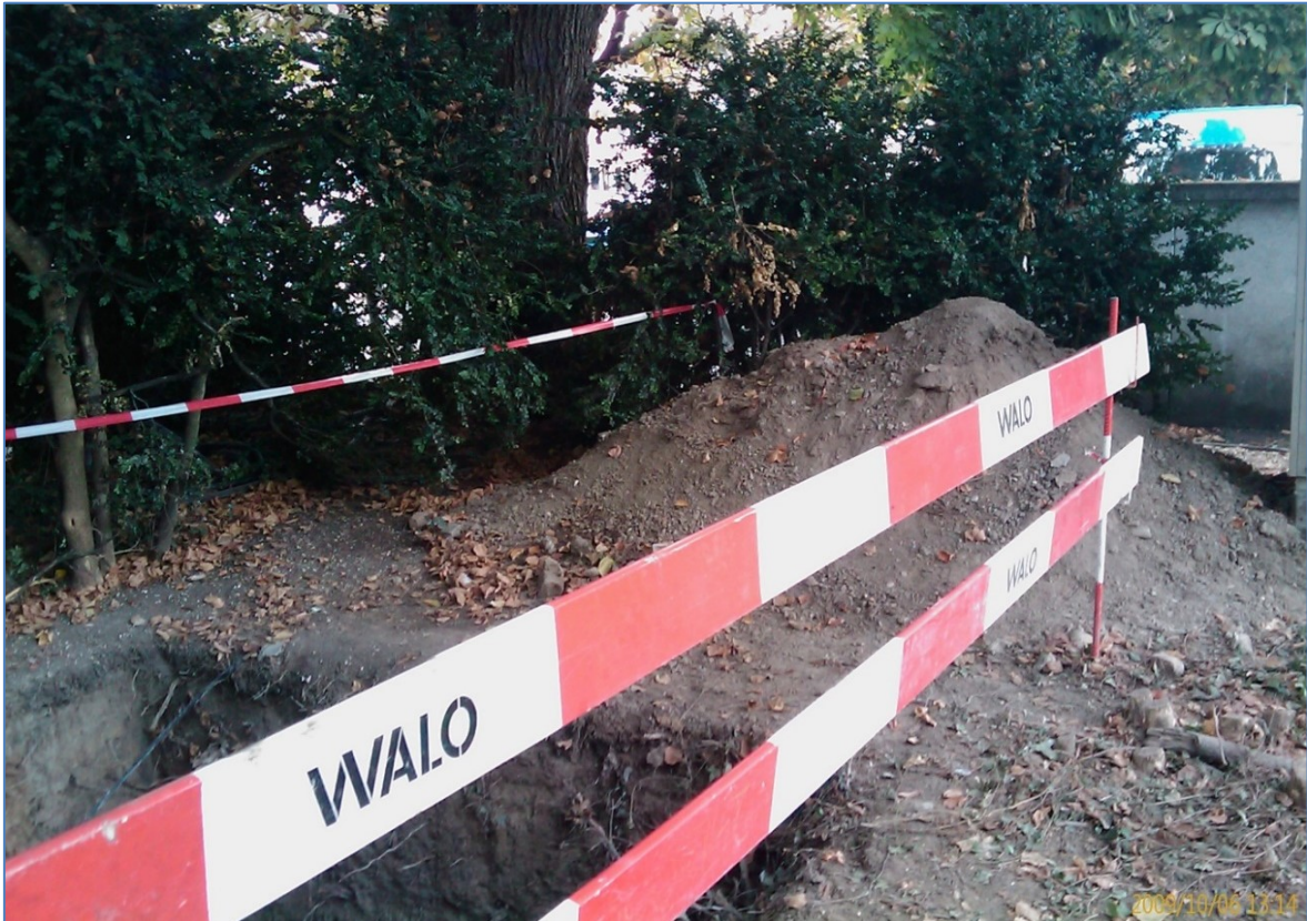
Abbildung 12: Ansicht in Richtung Südwest, Aufschüttungen und Grabungsarbeiten 2009 im Wurzelumfeld innerhalb der inneren kritischen Wurzelzone (eigene Aufnahme)
