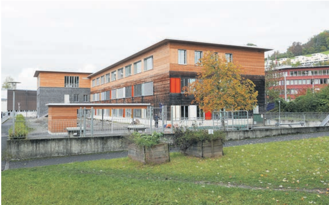
Dank der Aufstockung des Traktes A im «Würzenbach» hat es in diesem Gebiet langfristig genügend Schulraum.
