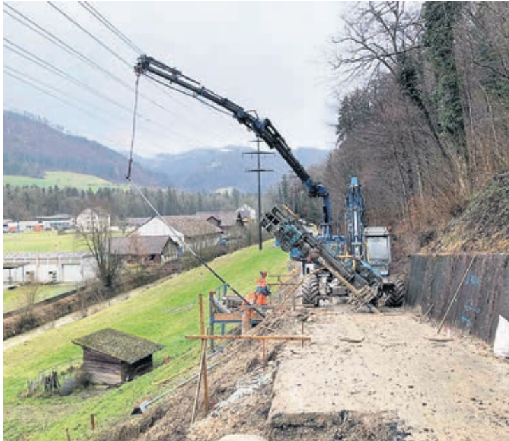
Mit einer Spezialmaschine werden zur Sicherung der Strasse Bohrpfähle ins Erdreich und in den Fels getrieben.
