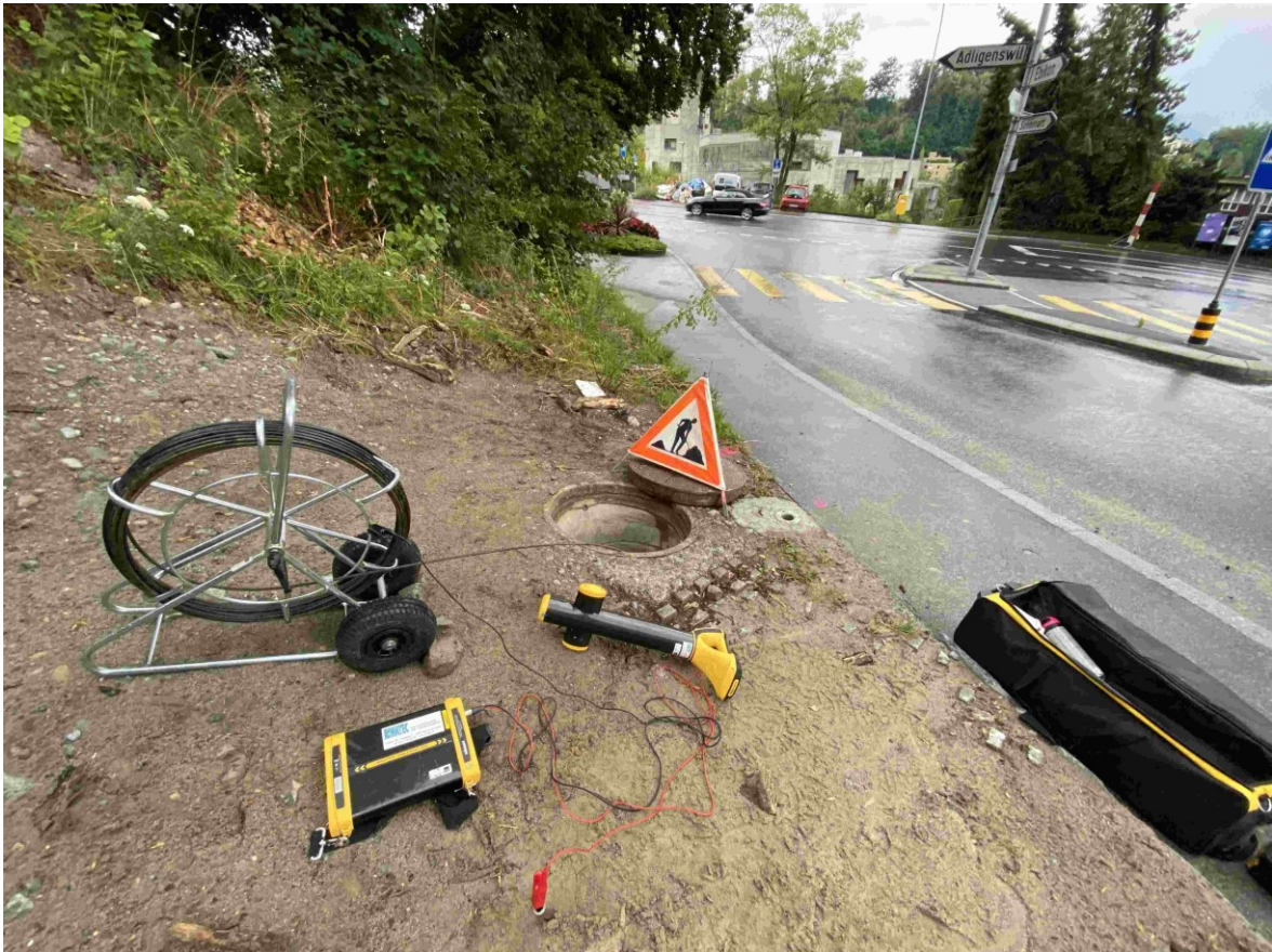
Abbildung 4: Auslegeordnung des Materials, welches bei einem Schacht an der Schlösslihalde für die Untersuchung der Bachleitung verwendet wird. (Foto: Emch+Berger WSB AG)
