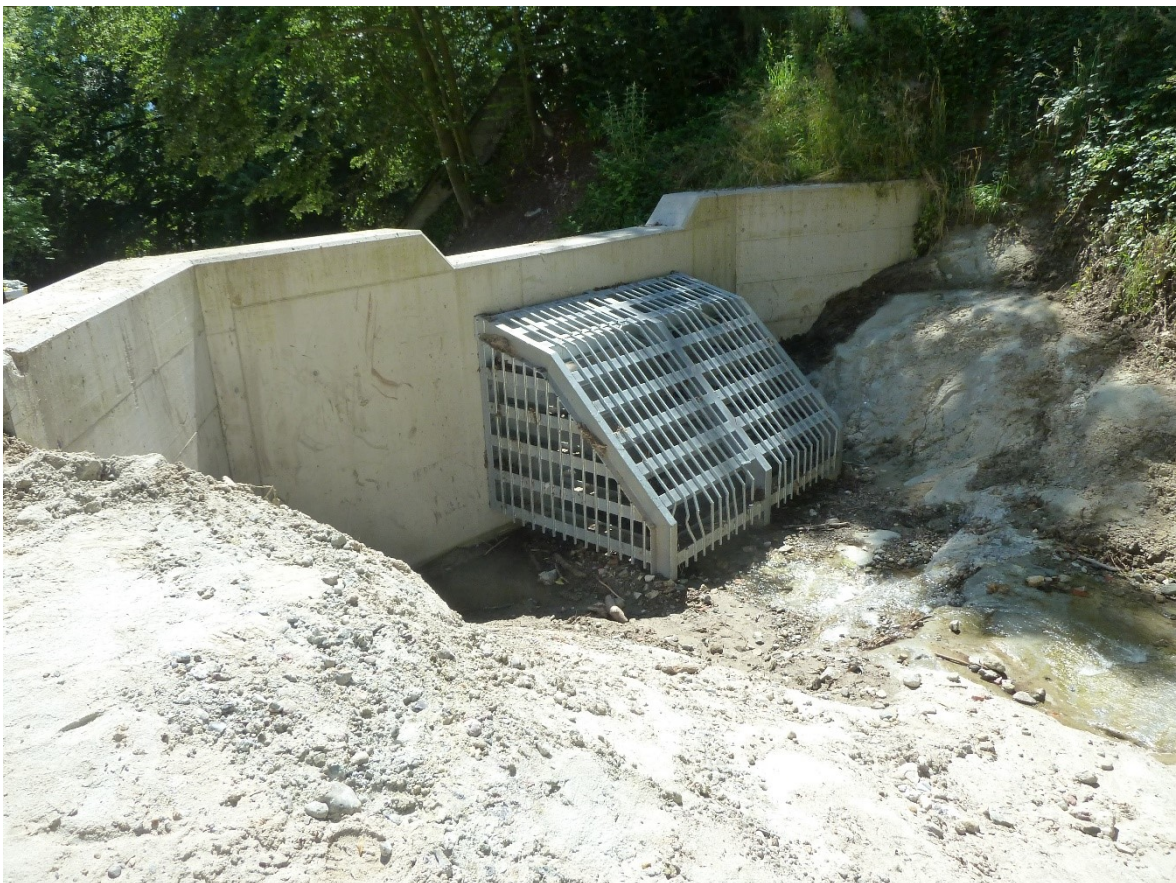
Abbildung 1: Der 2018 neu gebaute Geschiebesammler Gerlisbergbach mit Korbwehre (Foto: oeko-b AG)
