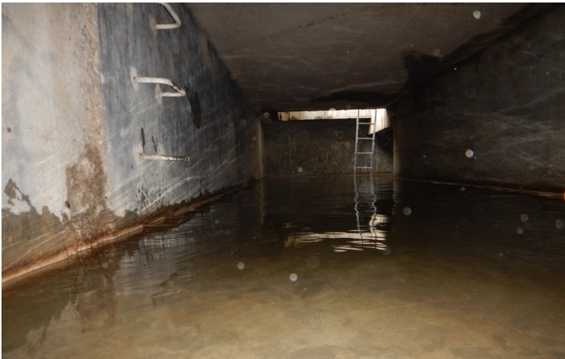
Abbildung 3: Unterirdisches, ursprünglich als Regenklärbecken konzipiertes Bauwerk an der Ecke Schädritstrasse und Schösslihalde. Dieses wird nun im Rahmen der Sofortmassnahmen geöffnet und für den Notfall zugänglich gemacht wird. (Foto: Stadt Luzern)
