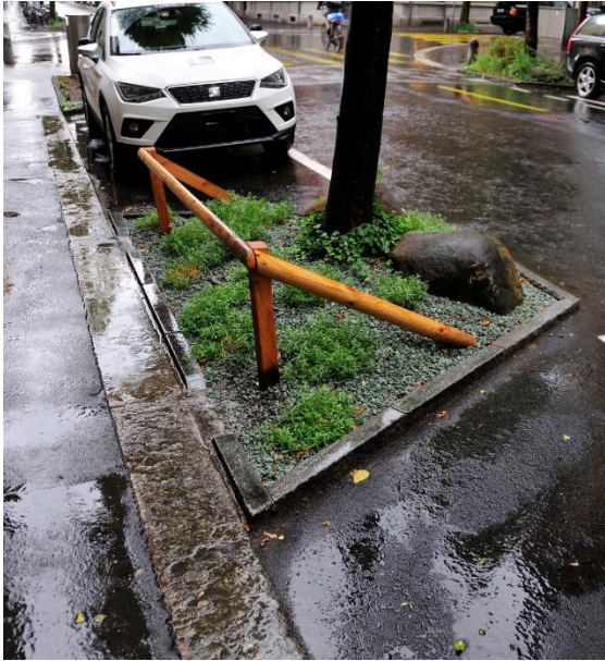
Abb. 10: Klimaangepasste Baumscheiben und Baumgruben: Als Bestandteile des integralen Regenwassermanagements (Schwammstadt)
