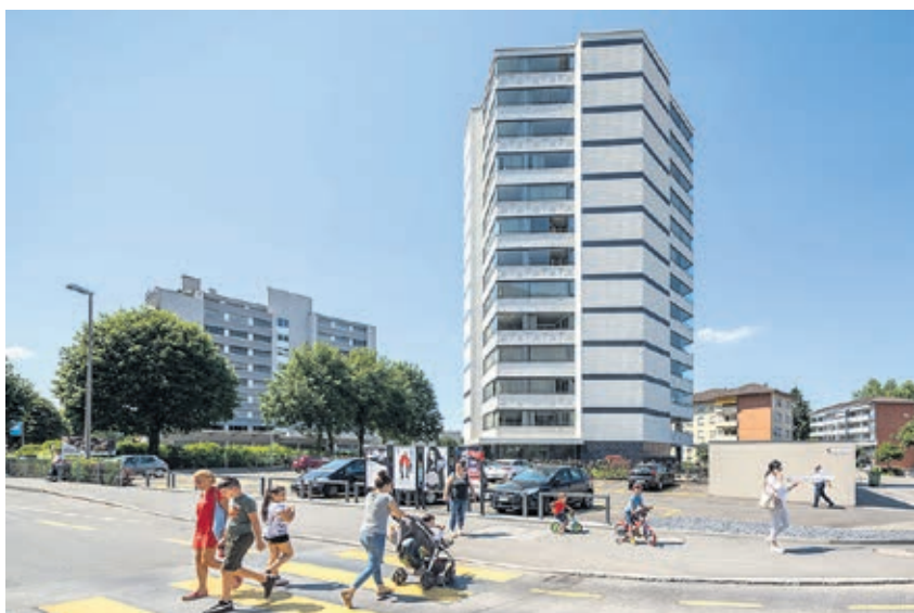
Die Baugenossenschaft Matt hat das Hochhaus Fanghöfli 2013 von einer privaten Besitzerin erworben und die 36 Wohnungen saniert.
