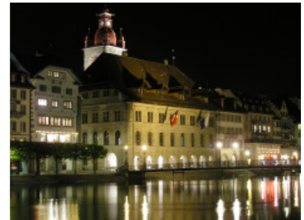
Bestehende Beleuchtung Südfassade Rathaus
