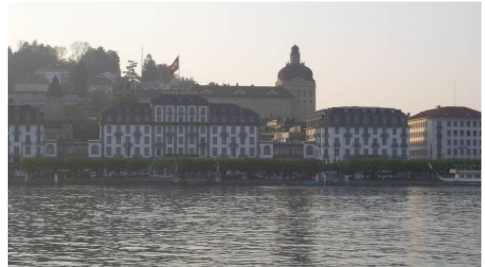
Ansicht des SUVA-Gebäudes vom Seeufer bei Tag (Bestand)
