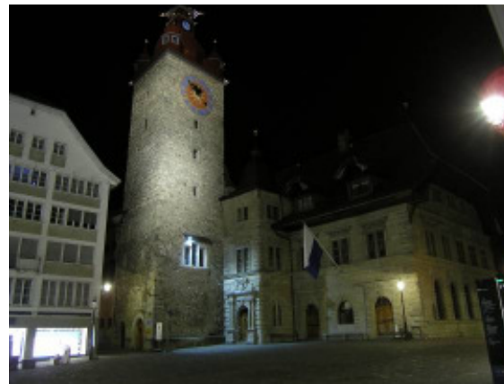
Bestehende Beleuchtung Nordfassade Rathaus
