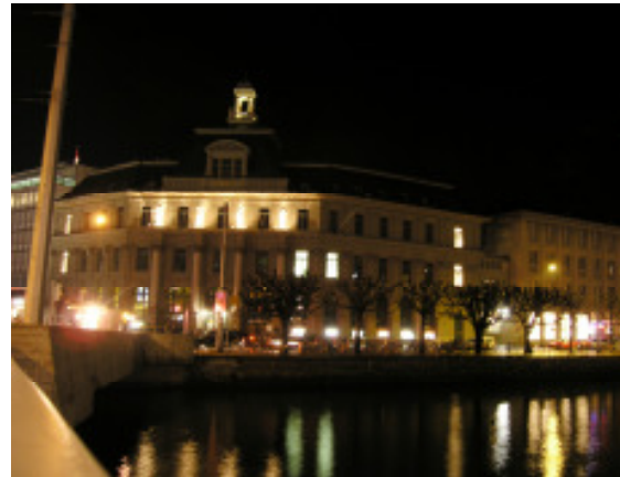
Bestehende Beleuchtung Hauptpost
