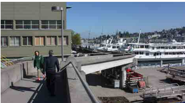
Hafenanlage mit Fussgängersteg
