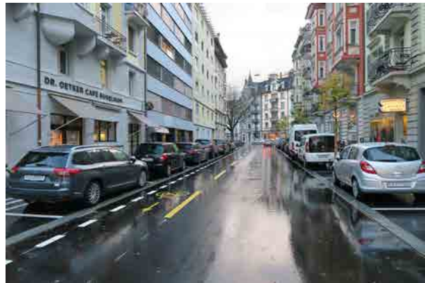
In den Seitenstrassen fast durchgehende Längsparkfelder, welche den Querbezug einschränken
