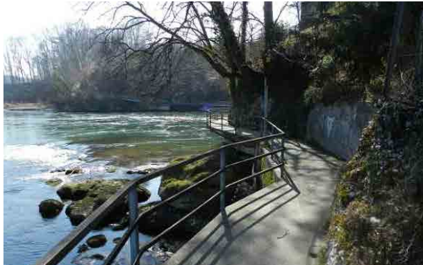
Referenzbild: Steg zur Schliessung von Lücken (Aare bei Olten, allerdings zu schmal für Velo und Fussgänger nebeneinander)
