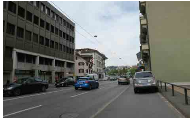
Verkehrsorientierte Obergrundstrasse ohne Aufenthalts- und Bewegungsqualität.
