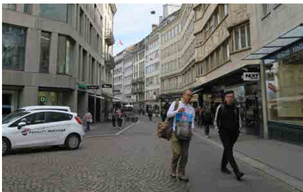
Grendel: Fahrgasse mit Trottoirs, Belagsschäden, kaum Sitzmöglichkeiten, parkierte Autos
