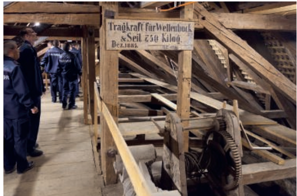
Gebäudekenntnis Dach Jesuitenkirche
