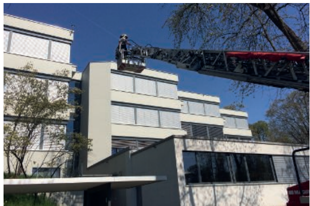
Stellung am Gebäude
