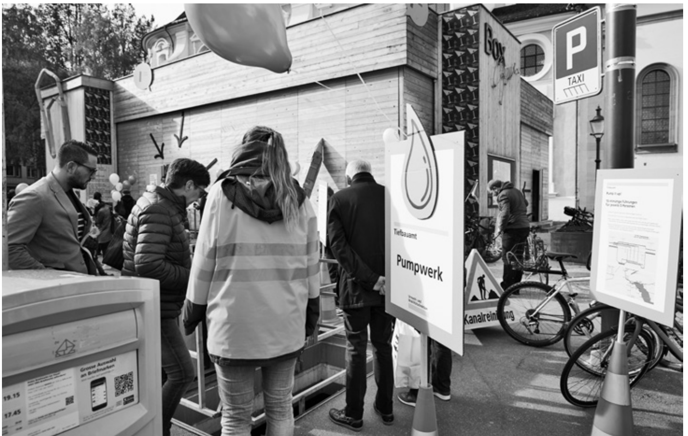
Das Tiefbauamt ermöglichte Interessierten einen Blick in das Pumpwerk unter dem Theaterplatz.
