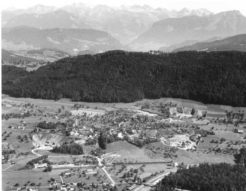
Abb. Fotografie ehemalige Kiesgruben Feld, Gasshof und Jodersmatt (v.l.n.r) 1952
