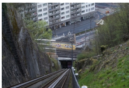
Abb. Referenzobjekt Gütschbahn
