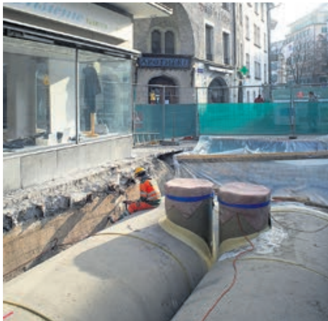
Nach der Instandsetzung des Kanals wird das Abwasser durch glasfaserverstärkte Kunststoffröhren geleitet.
