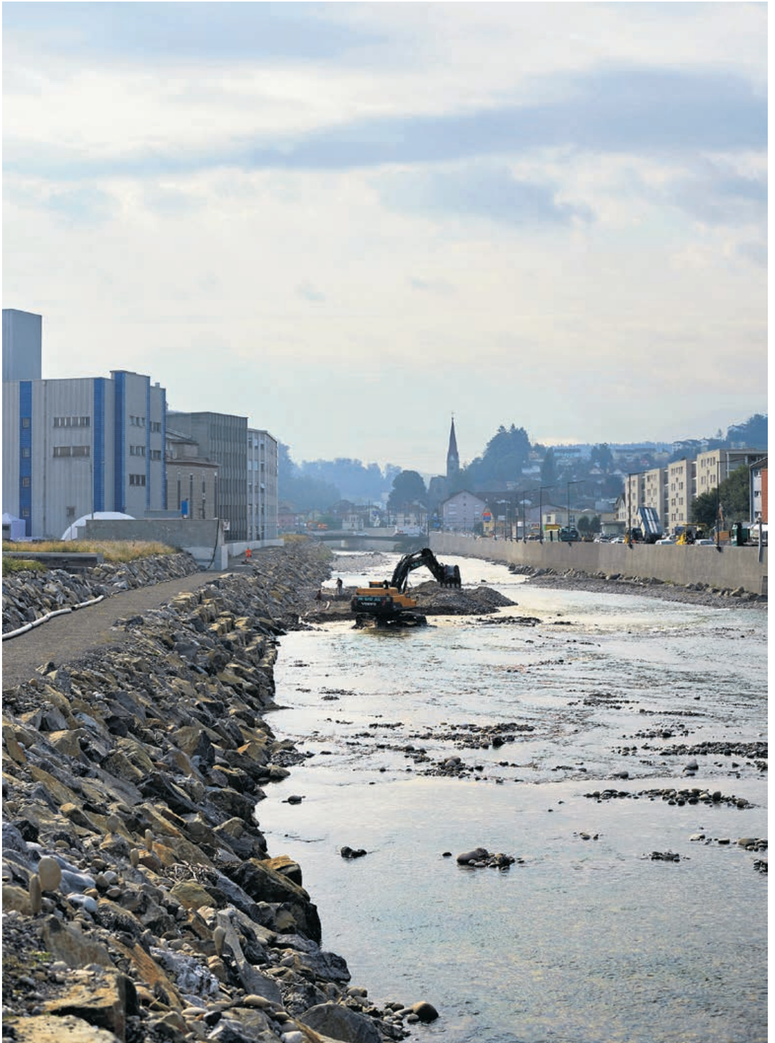
Die Arbeiten für den Hochwasserschutz sind mittlerweile abgeschlossen. Unter anderem wurde die Sohle der Kleinen Emme verbreitert. Am rechten Ufer wurde eine neue Mauer gebaut. Am linken Ufer wurden ein Gehweg sowie eine Mauer aus Natursteinen erstellt.
