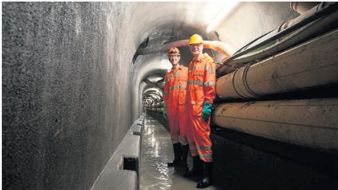
Urs Widmer, Leiter Abwasserwirtschaft Real (links), und Bernhard Gut, Energiebeauftragter der Stadt Luzern, im Kanal am Löwengraben. Die Abwasserwärmenutzung ist ein Beitrag zur 2000-Watt-Gesellschaft.
