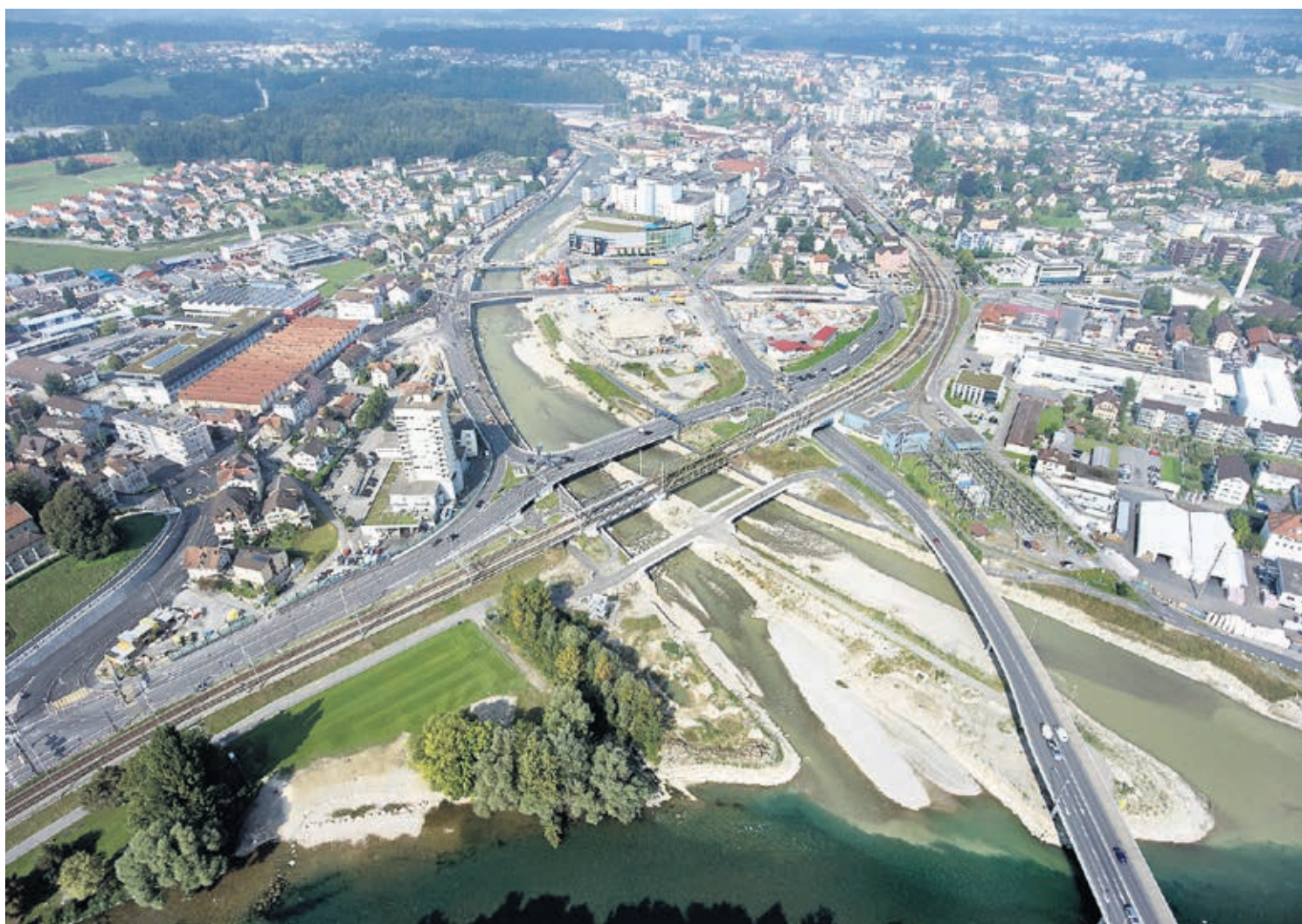
Luzern Nord im Juni 2013 (oben) und im September 2016 (unten): Durch die neue Verkehrsführung sind am Seetalplatz freie Flächen entstanden, die ab 2018 bebaut werden. Reussbühl ist dank der Umfahrungsstrasse vom Durchgangsverkehr befreit. Die Arbeiten für den Hochwasserschutz sind abgeschlossen.
