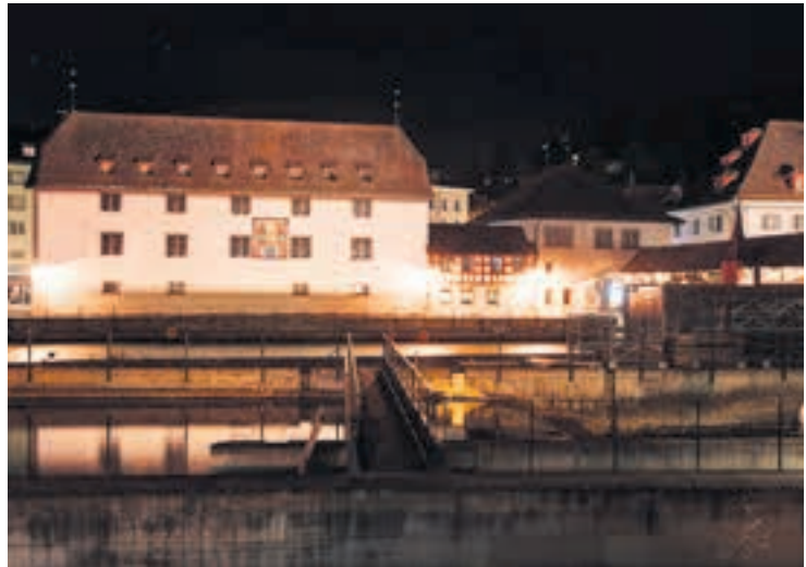
Dank der neuen Beleuchtung werden die Fassaden und Dächer sanft hervorgehoben, ohne dass Licht in den Nachthimmel gelangt.
