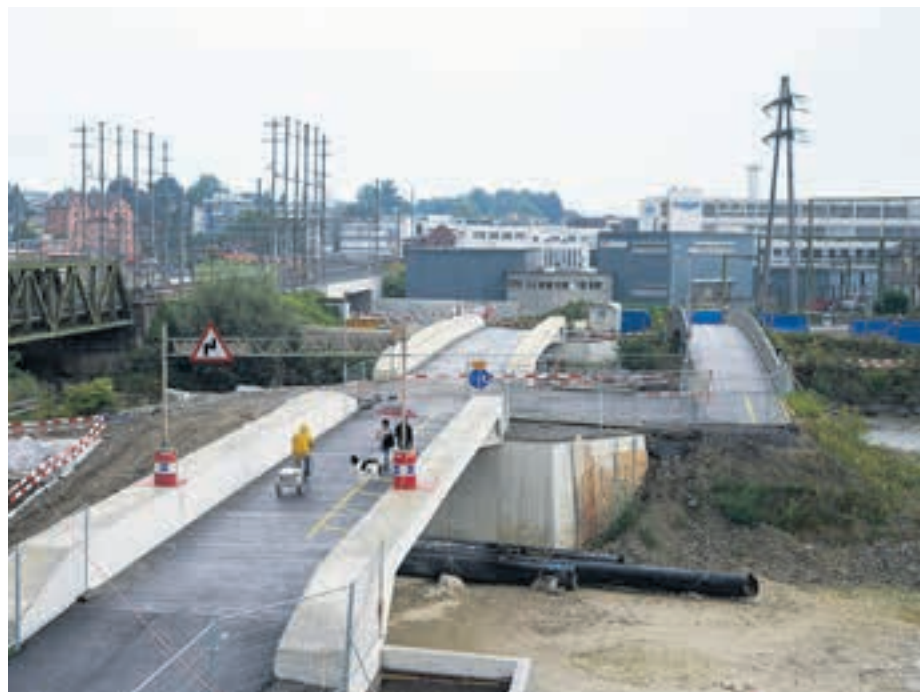
Die neue Fussgänger- und Velobrücke über die Kleine Emme. Der zweite Flussarm (vorne) wird Anfang 2017 fertiggestellt.
