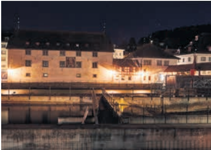
Mit der alten Beleuchtung am Uferweg wurde das Historische Museum Luzern nur ungleichmässig erhellt.
