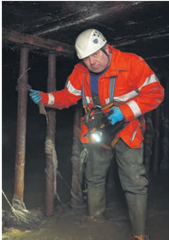
Markus Furrer vom Tiefbauamt kontrolliert den Krienbachkanal unterhalb der Burgerstrasse, der in den nächsten Jahren saniert werden muss.
