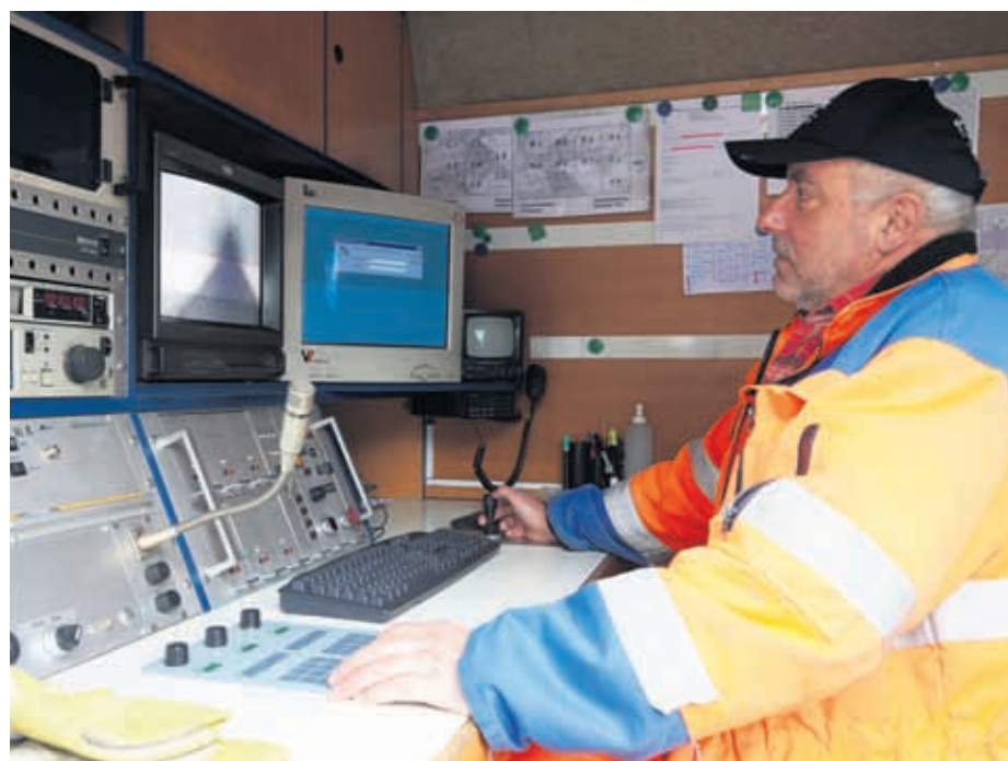
Operateur Walter Scheuber steuert die Kamera im Untergrund und kontrolliert den Zustand der Kanalisation.
