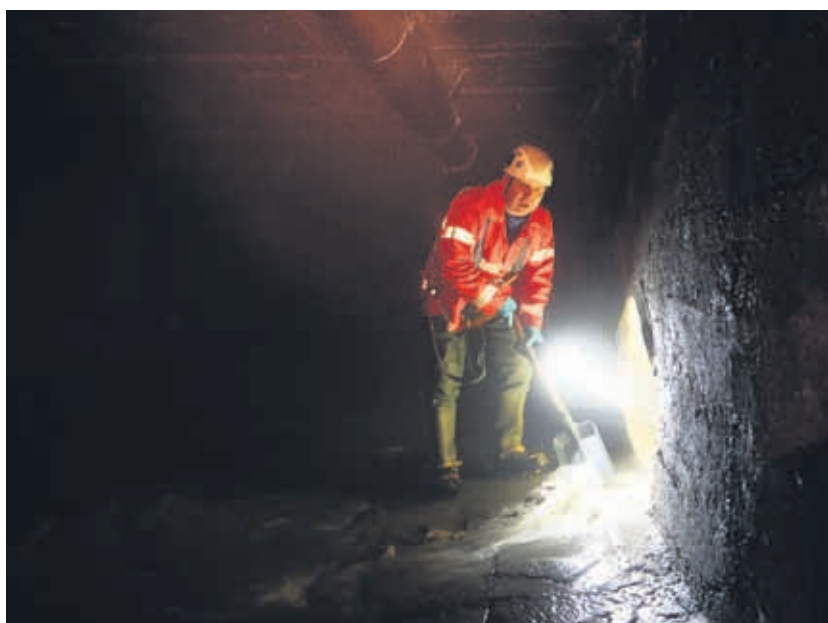
Krienbachkanal unterhalb der Obergrundstrasse: Spetter Markus Furrer vom Tiefbauamt sorgt dafür, dass das Abwasser abfliessen kann.
