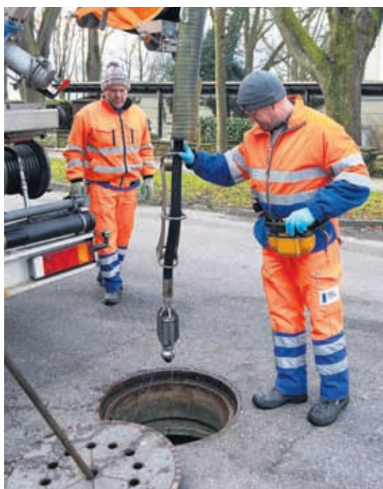
Oswin Wicki lässt den Hochdruckschlauch in den Kanal beim Verkehrshaus hinunter.
