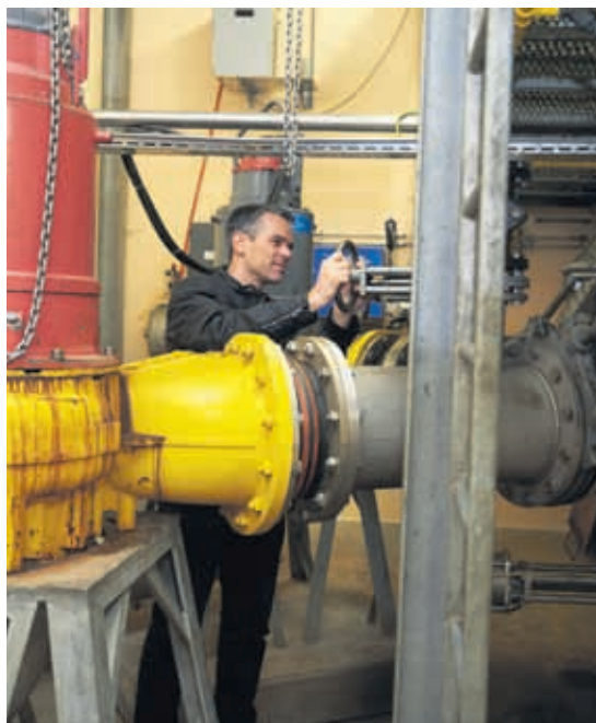
David Cathomas, Leiter Kanalunterhalt, kontrolliert das Pumpwerk beim Verkehrshaus.
