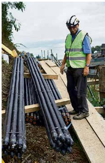
Mit sechs bis zehn Meter langen Ankern werden die Betonsockel am Fels befestigt.
