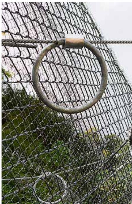
Die Schlaufen in den Spannseilen sorgen dafür, dass die Netze dem Druck standhalten.
