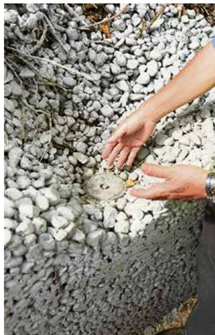
Ein zweiter Sockel aus Sickerbeton sorgt dafür, dass das Wasser im Hang abfliessen kann.
