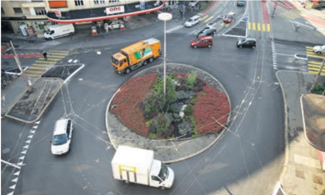
Mehr Sicherheit: Fussgängerstreifen, die über zwei Fahrspuren führen, wurden mit einer Schutzinsel ergänzt, die Kreiselausfahrten auf einen Fahrstreifen reduziert.
