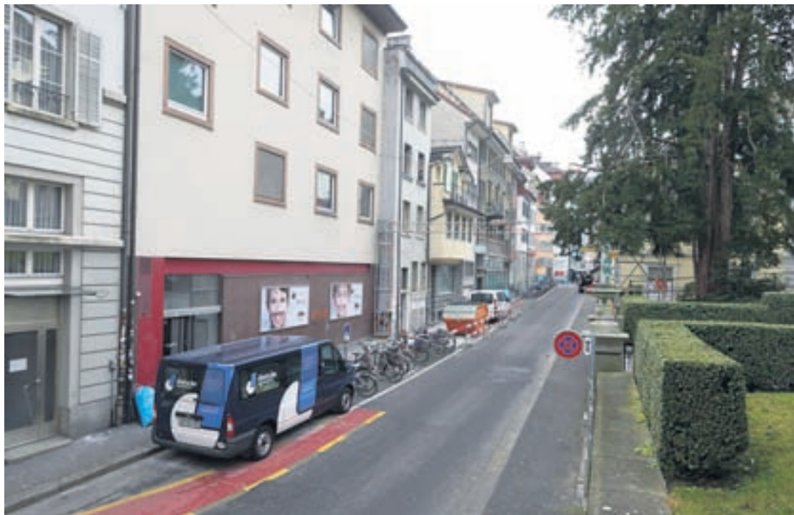
Der Abwasserkanal unter dem Löwengraben und der Grabenstrasse stammt aus dem 16. Jahrhundert.
