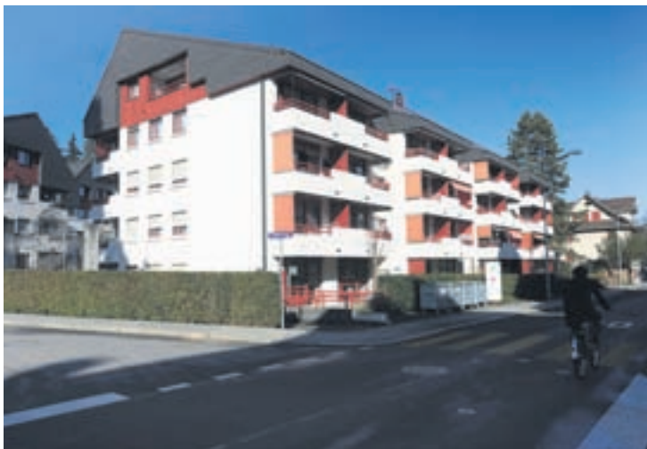
Die beiden Häuser der Alterssiedlung Guggi an der Taubenhausestrasse sollen bis 2018 einem Neubau mit mehr Komfort weichen.
