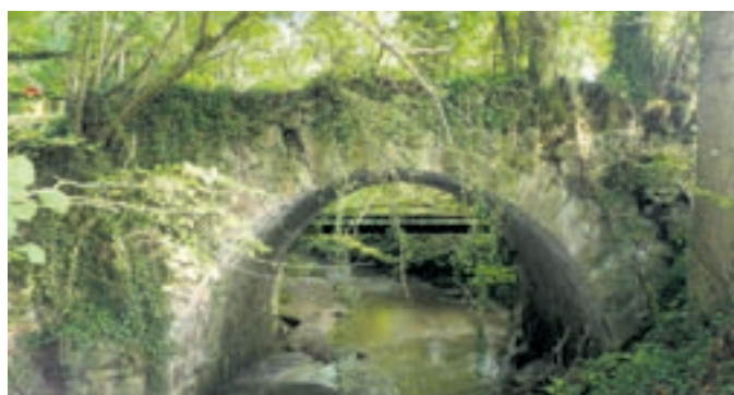
Die Sagelibrücke auf dem Littauerberg an der Gemeindegrenze Luzern/Neuenkirch.
