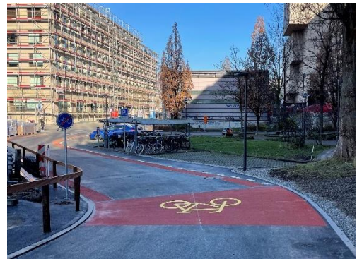
Abbildung 4: Flächige Einfärbung und Längsbänder auf dem Veloweg Rösslimatt. Die FGSO-Fläche deutet auf das Ende der Mischverkehrsfläche mit dem MIV und Beginn des Velowegs hin.
