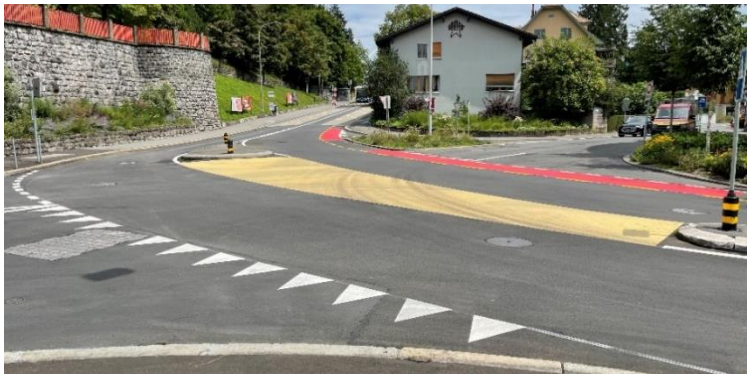
Abbildung 2: FGSO-Beispiel an der Kreuzung St.-Karli-Strasse und Spitalstrasse
