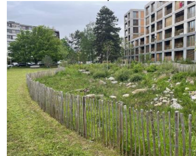
Abbildung 24: Versickerungsmulde Biodiversität Plaine du Loup, Lausanne (Quelle: HOLINGER AG)
