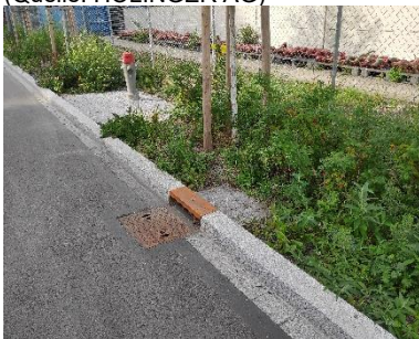
Abbildung 61: Baumstandort mit Zufluss Strassenwasser im Winter- und Sommermodus, Giessereistrasse, Zürich (Quelle: Entsorgung + Recycling Zürich)
