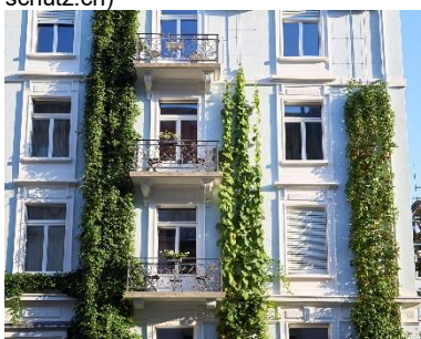
Abbildung 52: Bodengebundene Vertikalbegrünung am Hotel Alma, Mainausstrasse, Zürich (Quelle: Jakob AG)
