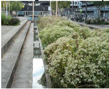
Abbildung 91: Naturnahe Reinigung in einem Versickerungsbecken über eine Bodenpassage, Turbinenplatz, Zürich (Quelle: HOLINGER AG)
