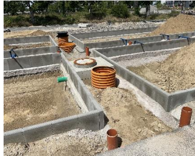
Abbildung 47: Verdunstungsbeete im Schumacher-Quartier, Berlin DE, im Bau (Quelle: Tegel Projekt GmbH)
