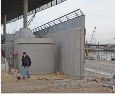
Abbildung 79: Zisternen für die Regenwasserspeicherung und Nutzung an der HafenCity Universität Hamburg DE (Quelle: tab, bauverlag.de)
