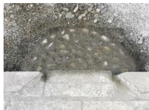
Abbildung 6: Erosionsschutz bei Versickerungsanlagen, links: Neustadtstrasse Luzern, rechts: Grenzach-Wyhlen DE (Quelle: HOLINGER AG)
