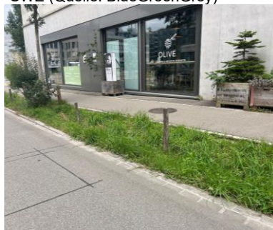
Abbildung 29: Zulauf Grünstreifen, Randstein Welle (erhöht bei Baum, abgesenkt dazwischen), Allmendstrasse, Zürich (Quelle: HOLINGER AG)
