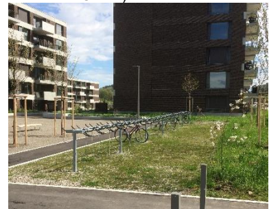
Abbildung 39: Veloparkplatz mit Schotterrassen, Winterthur (Quelle: HOLINGER AG)
