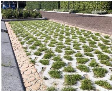
Abbildung 34: Rasengittersteine Parkplatz, Haaren NL (Quelle: Rain(a)Way)
