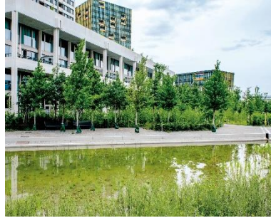
Abbildung 44: Retentionsteich im Wolkenwerk, Zürich (Quelle: Hochparterre AG)
