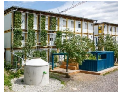
Abbildung 87: Speicherung des Dachwassers für Bewässerung in einer oberirdischen Zisterne, Rosensteinviertel, Stuttgart DE (Quelle: Julian Rettig)
