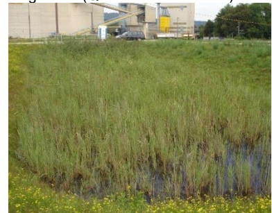
Abbildung 96: Sand-Schilffilter in der SABA Ristet August (Quelle: Zürcher Umweltpraxis ZUP)
