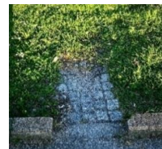
Abbildung 6: Erosionsschutz bei Versickerungsanlagen, links: Neustadtstrasse Luzern, rechts: Grenzach-Wyhlen DE (Quelle: HOLINGER AG)
