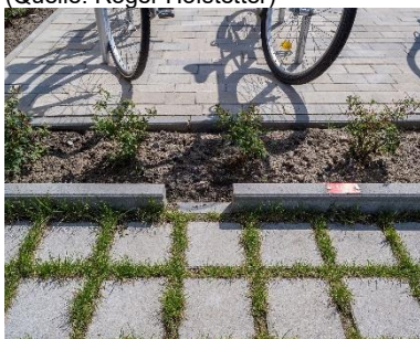
Abbildung 40: Parkplatz mit Plattenbelag mit breiten, humusierten Fugen und Veloparkplatz mit schmalen Fugen (Quelle: Andreas FranzXaver Süß)
