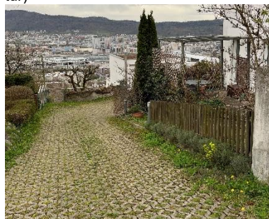
Abbildung 35: Rasengittersteine Zufahrtsstrasse Wohnhaus, Zürich (Quelle: HOLINGER AG)
