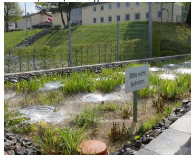
Abbildung 95: Begrüntes Filterbeet zur naturnahen Wasserreinigung (Quelle: Naturbad Aura an der Saale)
