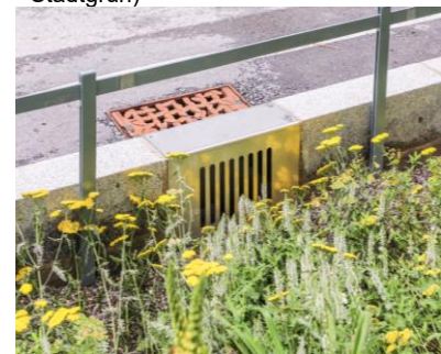
Abbildung 30: Zulauf Tiefbeet, mit Schlammsammler und Einlaufgitter, Leonhardgürtel, Graz AT (Quelle: 3:0 Landschaftsarchitekten)
