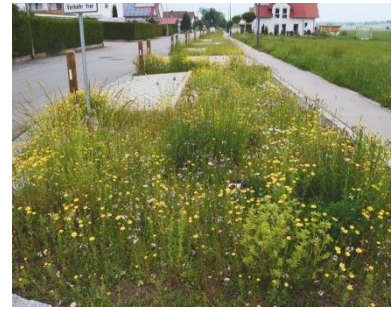
Abbildung 93: Versickerungsmulde zur naturnahen Reinigung des Regenwassers von Strasse, Parkplatz und Trottoir, Benningen DE (Quelle: Reinhard Witt)
