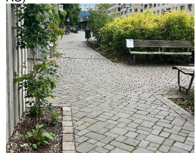
Abbildung 42: Plattenbelag mit schmalen Fugen auf Gehweg, Manegg, Zürich (Quelle: HOLINGER AG)
