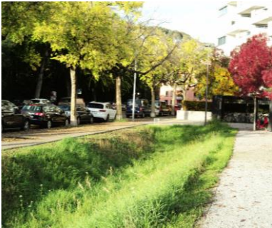
Abbildung 22: Versickerungsmulde Strassenraum, Sportweg, Zürich (Quelle: HOLINGER AG)
