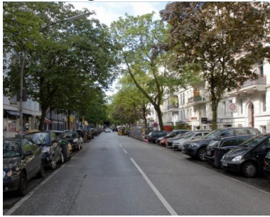
Abbildung 67: Beispiel Gemeindestrasse 3. Klasse im Bestand bei Trockenwetter, Hamburg DE (Quelle: Freie und Hansestadt Hamburg)
