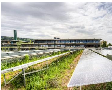
Abbildung 49: Extensive Dachbegrünung in Kombination mit PV-Anlage, ewz-Unterwerk, Zürich-Oerlikon (Quelle: naturschutz.ch)
