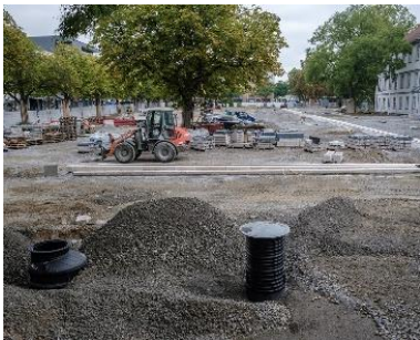
Abbildung 82: Unterirdische Rohrzisterne an einem öffentlichen Platz (Quelle: Stadt Ludwigsburg)
