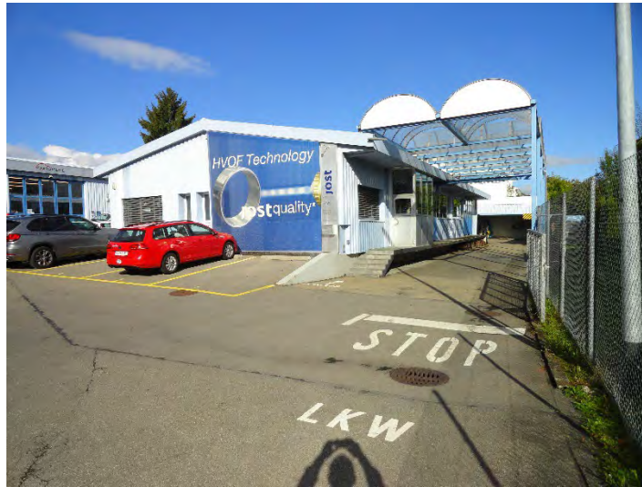
Abb. 25 Blick in Richtung Norden auf den Eingangsbereich der Jost AG (planteam 21.10.2016)
