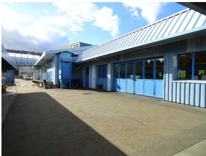
Abb. 24 Filteranlage, Kompressorraum und Werkstatt 3 Jost AG (planteam 21.10.2016)
