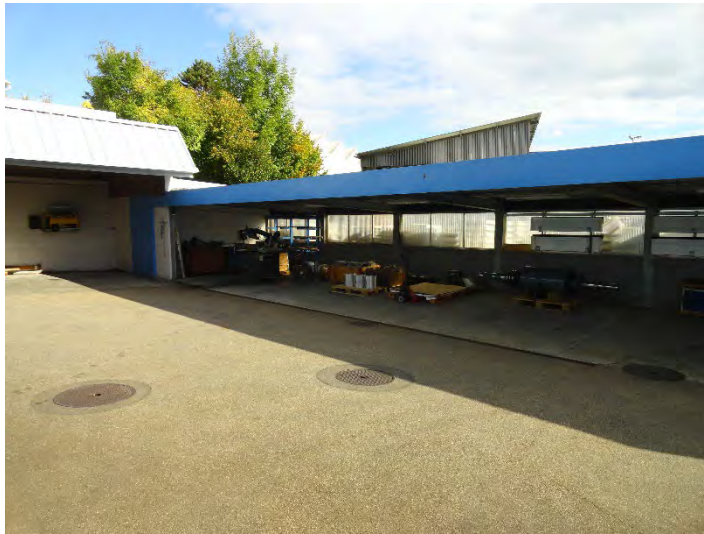
Abb. 22 östlicher Unterstand Jost AG (planteam 21.10.2016)
