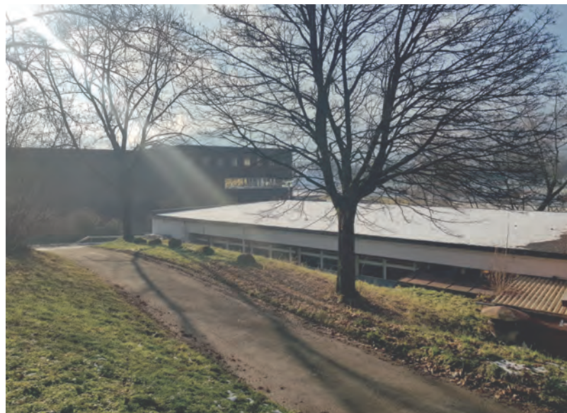
Sicht auf die Mossmattstrasse u. das Kegelbahn - Dach
