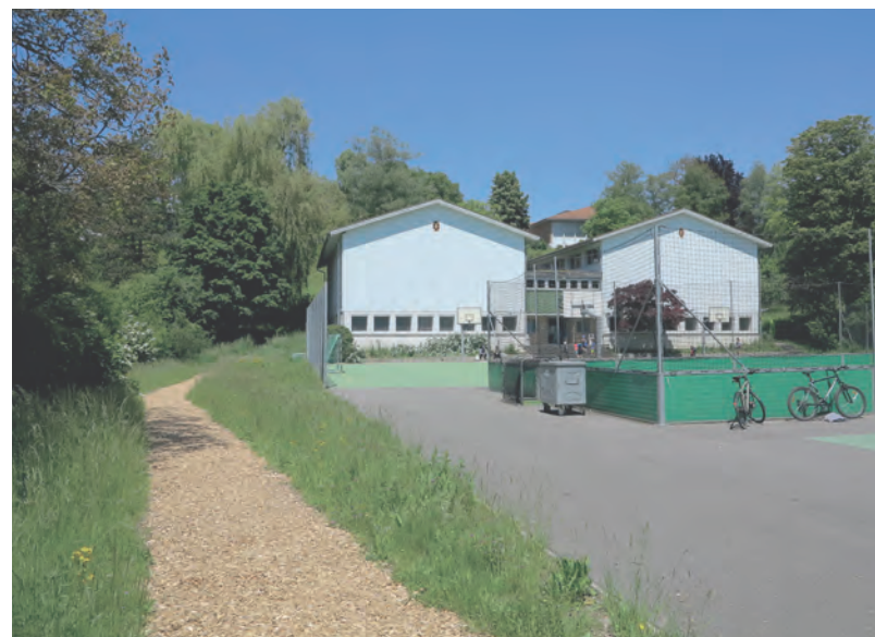
Die bestehende Turnhalle Hubelmatt
