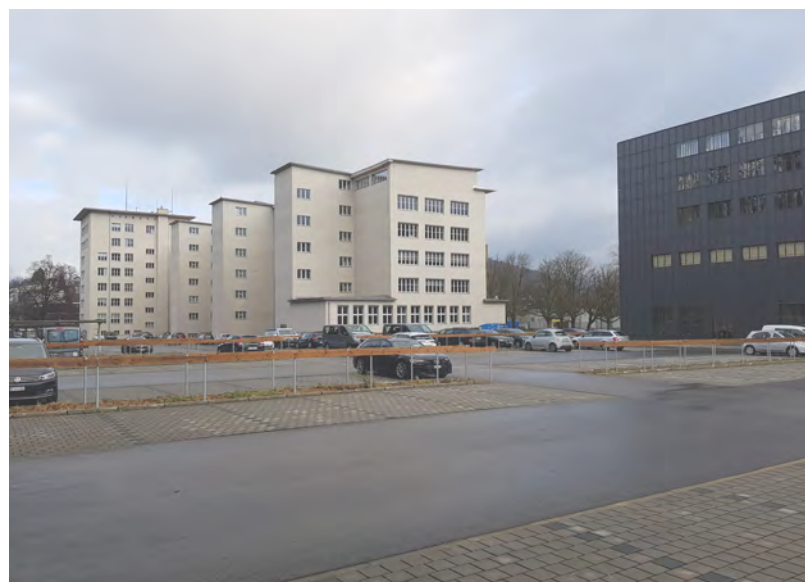
Blick auf Parkplatz richtung Nordosten
