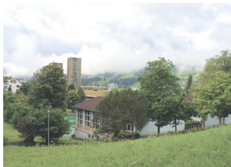
Sicht von der Hügelkuppe auf die Turnhalle Hubelmatt
