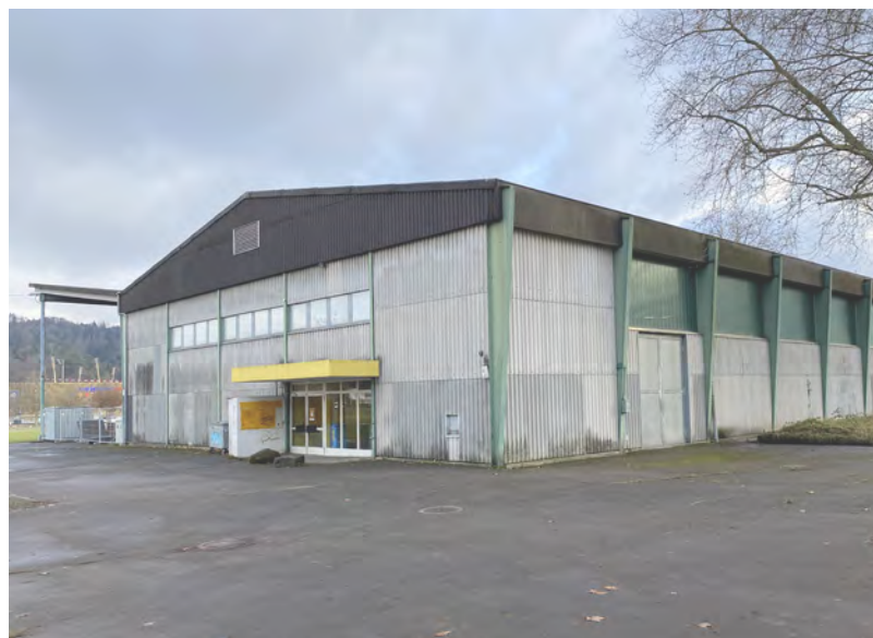
Blick auf den Eingang der Halle
