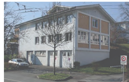
Schulanlage Hubelmatt, Hauswart- und Werkstattgebäude
