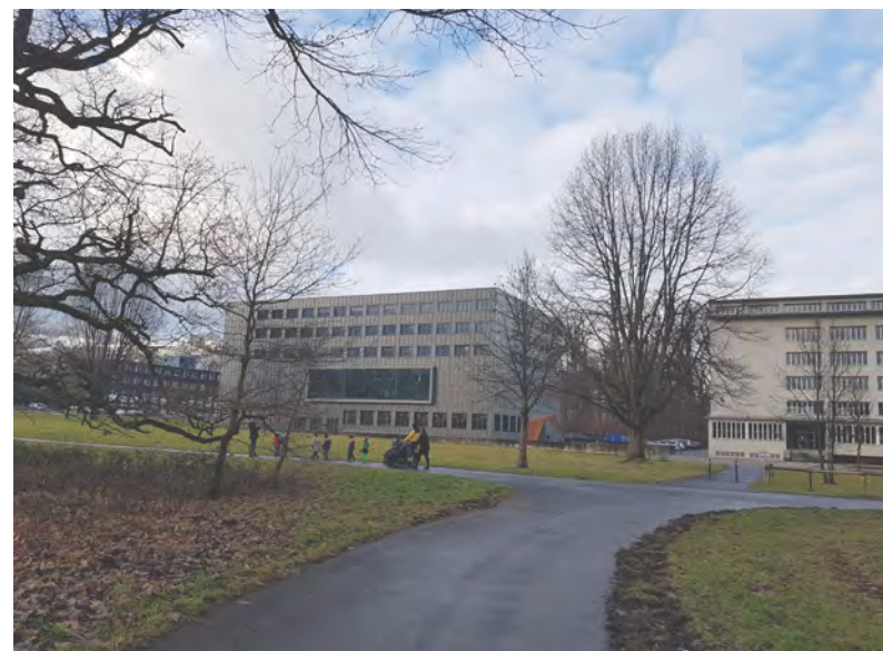
Blick richtung AAL-Gebäude
