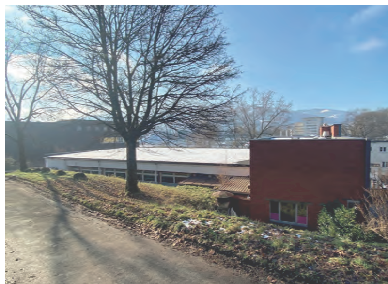
Dach der Kegelbahn
