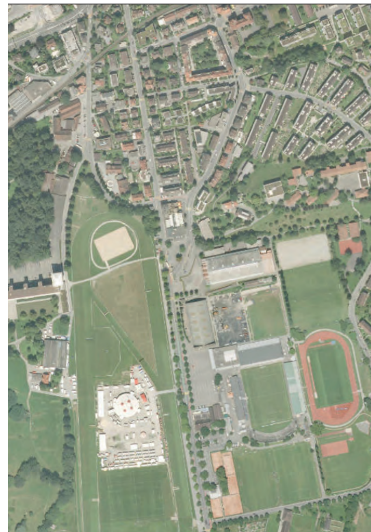
Luftbild Baustelle Messezentrum | 2008
