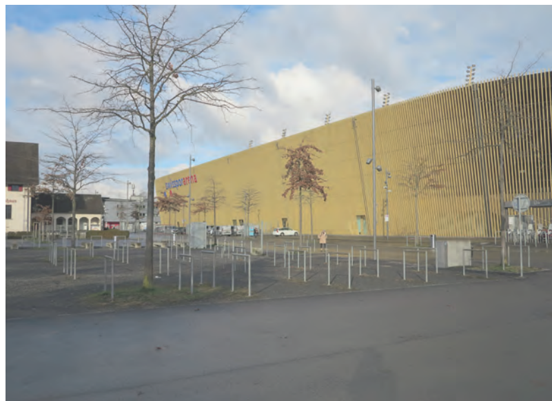
Veloabstellplätze auf der Vorzone
