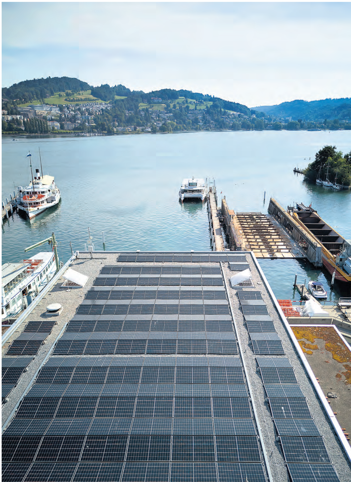
Blick in Richtung Energiewende: Sowohl die Solaranlage auf dem Dach der Shiptec AG als auch der Vierwaldstättersee liefern der Stadt Luzern wertvolle erneuerbare Energie.
