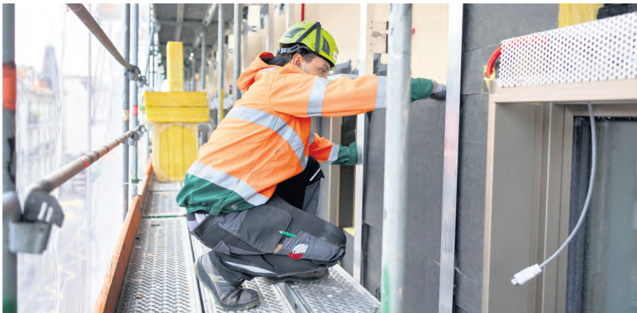
Eine umfassende Gebäudehüllensanierung (Aussenwände, Dach, Fenster) kann die Energieverluste um bis zu 80 Prozent reduzieren.
