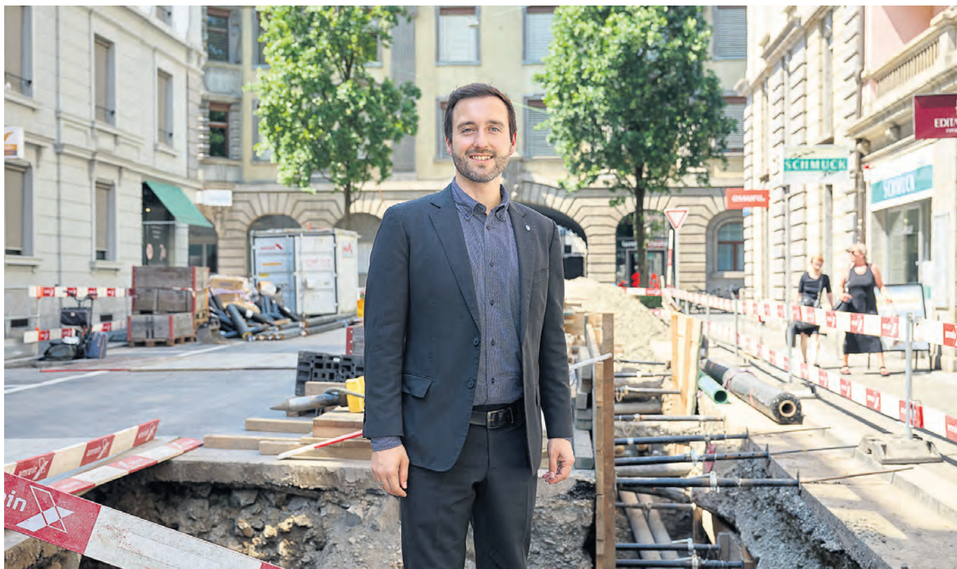
Stadtrat Marco Baumann vor einer Baustelle an der Stadthausstrasse. Die neu verlegten Leitungen im Untergrund braucht es, um auch das Stadthaus (im Hintergrund) an das See-Energie-Netz von ewl Energie Wasser Luzern anschliessen zu können.
