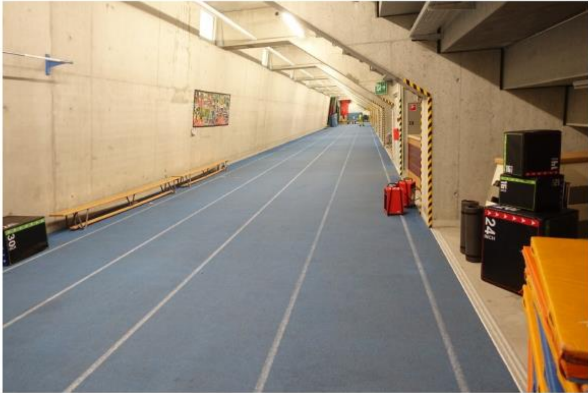
Abb. 5: Aktuelle Situation des Lauftunnels
