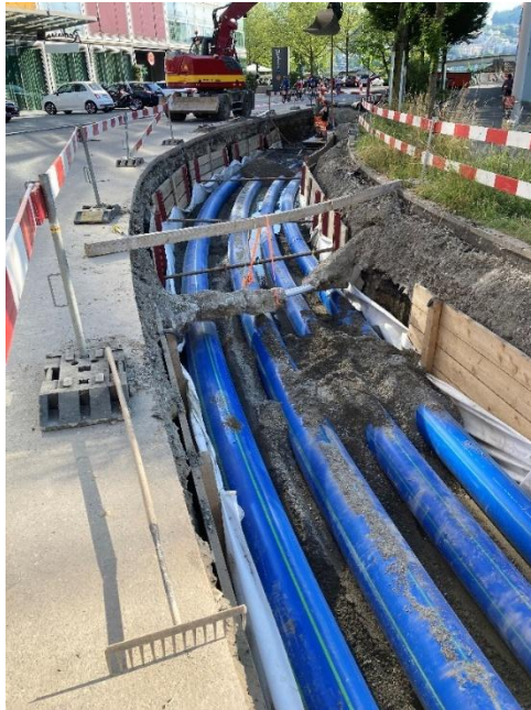
Abbildung 20 Impression Werkleitungs-dichte (See-Energie Luzern Zentrum, 2021, B+S)
