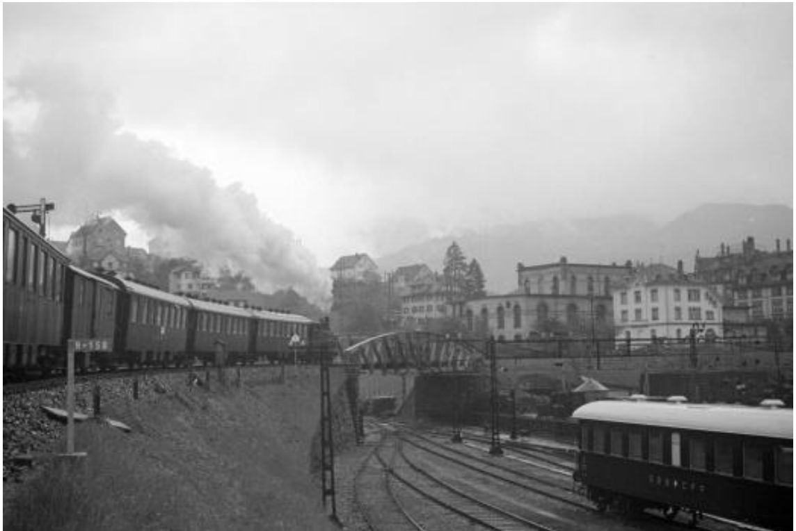
Abbildung 28 Der Bahndamm und die ehemalige Bogenbrücke der Brünigbahn (historische Aufnahme)
