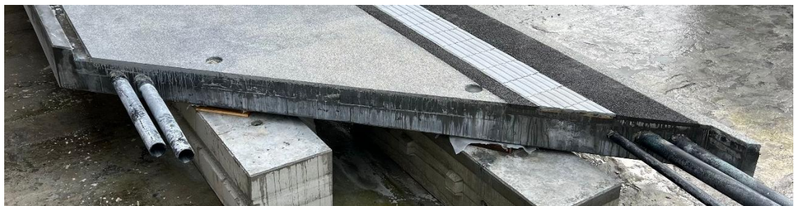
Abbildung 50 Beispiel UHFB mit unterschiedlicher Splittmatrixfarbe und taktilen Führungselement
