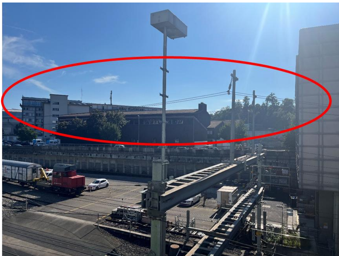
Abbildung 8 Vom Bau der Brücke betroffene Speiseleitungen Fahrstrom
