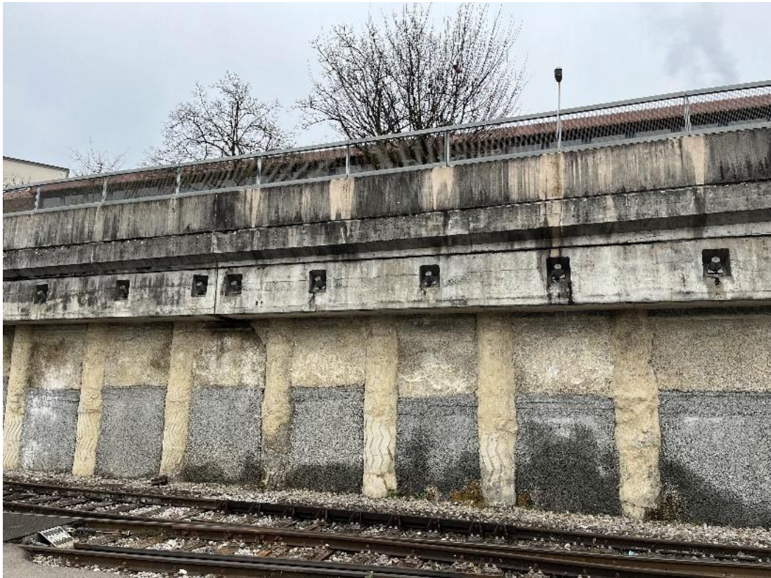
Abbildung 9 Rückverankerte, aufgelöste Bohrfahlwand – Fruttstrasse
