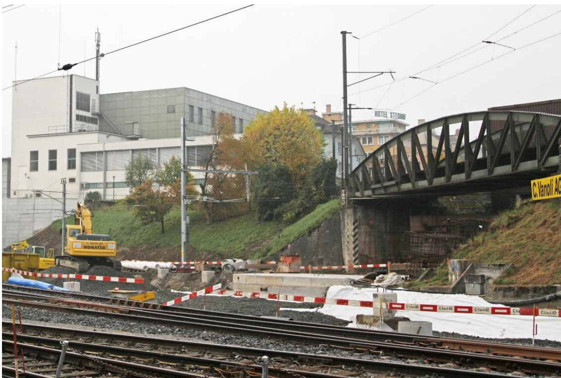
Abbildung 27 Der Bahndamm und die ehemalige Bogenbrücke der Brünigbahn (Oktober 2011)
