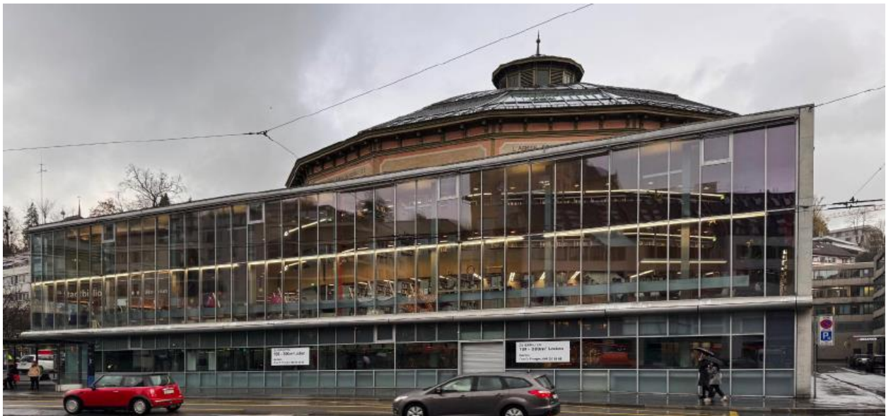
Abb. 2: Ansicht aktuelle Fassade, 2025
