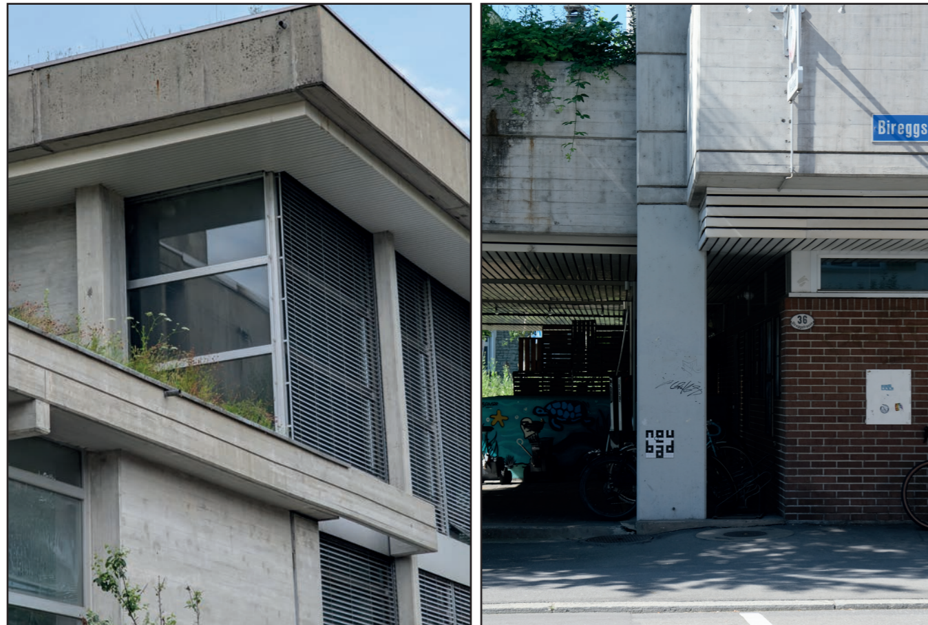
Abb. 36-37: Aussendetails der Fassade des Hallenbads Biregg. Links Eckansicht der Südfassade. Verflechtung und Gliederung der Bauglieder durch differenzierte Betonelemente sowie der Materialkontrast zwischen Sichtbeton, Glas und Aluminium werden hier besonders deutlich. Rechts die Auseinandersetzung mit tragenden und nichttragenden Strukturen durch den Kontrast zwischen Betonpfeiler und Rohziegelmauer. Zentrale Verbindungselemente: die Decke aus Metallprofilen. F. Gstöhl 2025.
