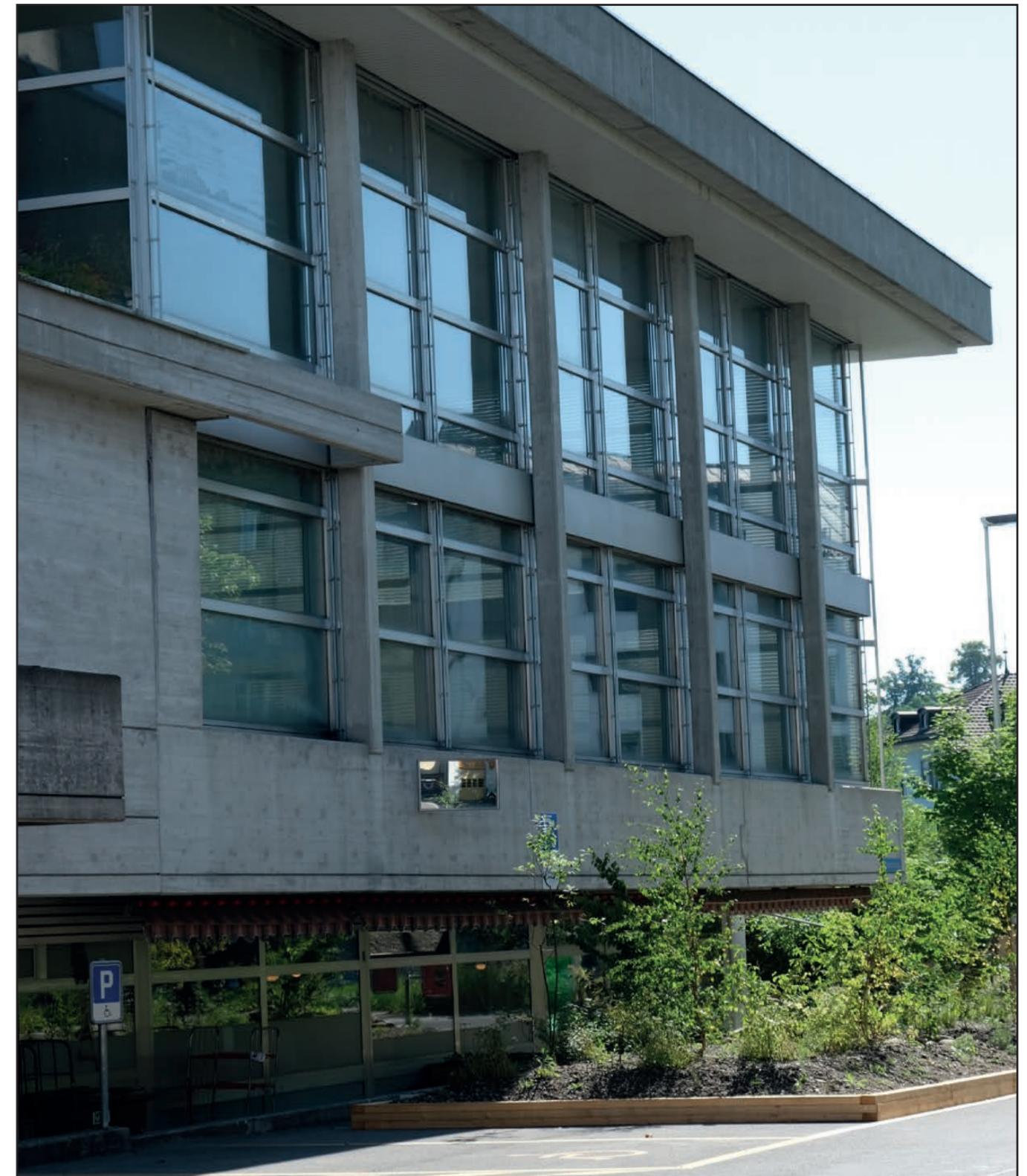
Abb. 38: Schrägansicht der Südfassade von der grossen Schwimmhalle. Auch hier zeigt sich eindrücklich die konstruktive Spannung und Zusammensetzung der einzelnen Fassadenelemente. Die Fassadenpfeiler stossen dabei nicht stumpf auf die breite Betonplatte, sondern sind mit einem Absatz aufgesetzt um deren tragende Bedeutung zu unterstreichen. F. Gstöhl 2025.
