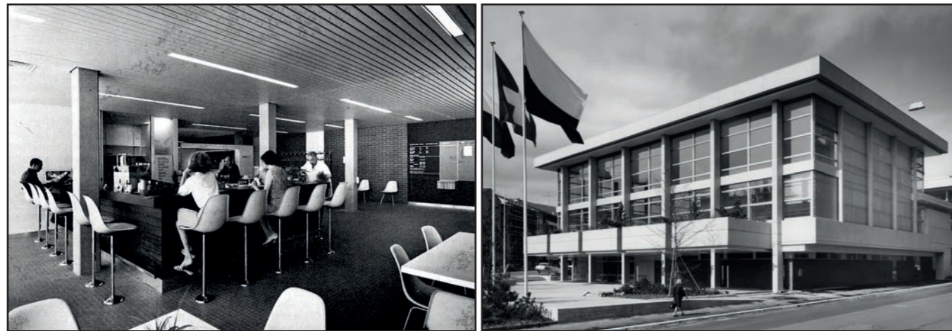
Abb 39-40: Das Hallenbad kurz nach der Eröffnung 1969. Links das Foyer mit der bis heute erhaltenen Snackbar und rechts die Hauptfront mit der markanten Überdeckung des Haupteingangs. Eröffnungsbroschüre Hallenbad Stadt Luzern 1969.
