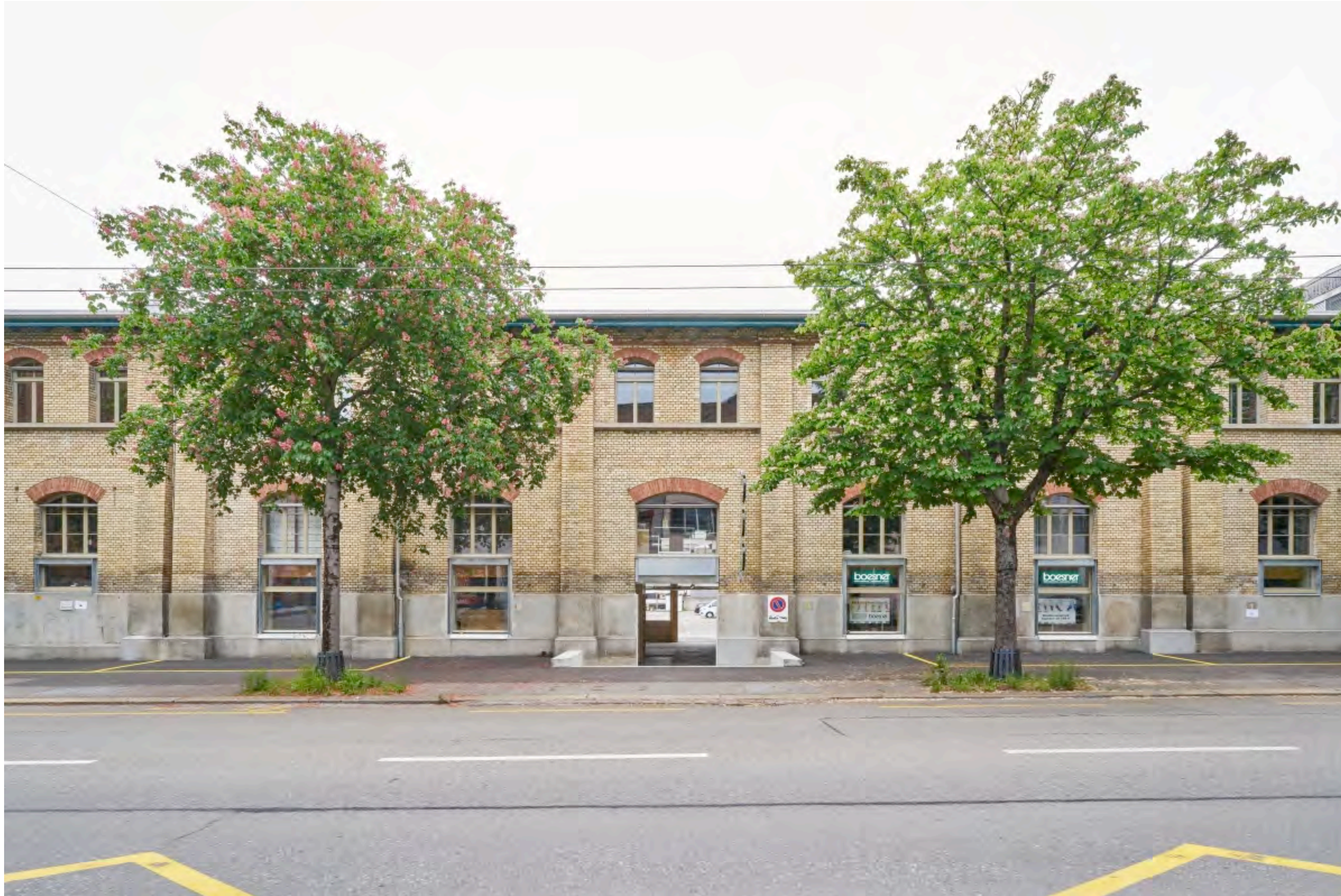
Werkstadt Zürich, Hohlstrasse
