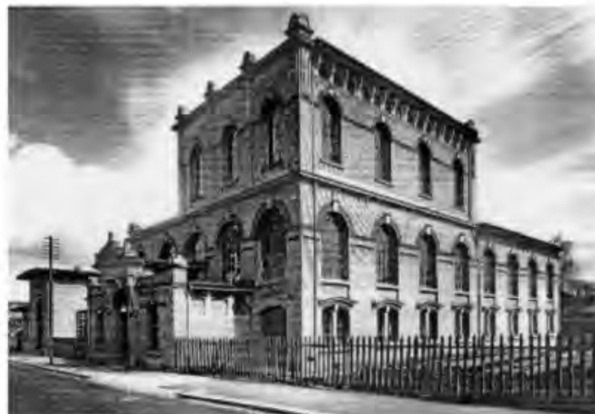
Abb. Historische Aufnahme des Transformatorgebäude / Quelle: unbekannt
