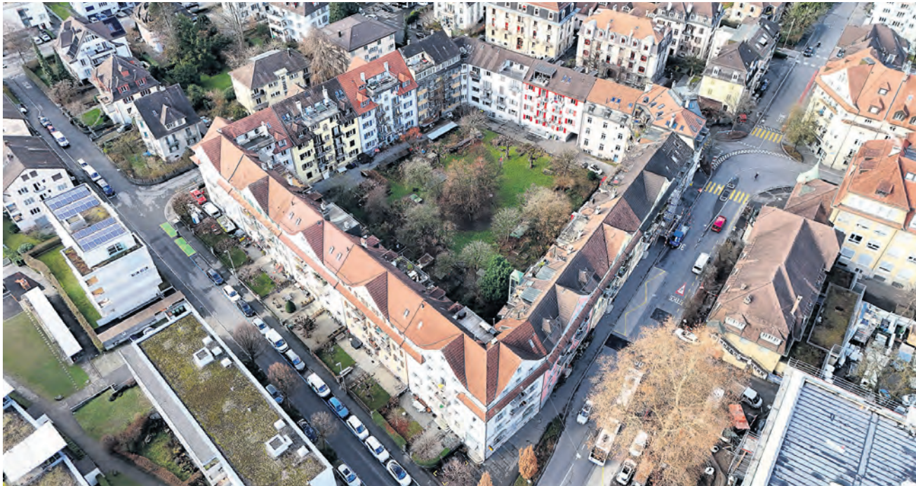
Die rund 100-jährige Blockrandbebauung Budelehof liegt direkt vis-à-vis des Schulhauses Moosmatt und umfasst 17 Gebäude samt einem begrünten Innenhof. Nun wird die Überbauung energetisch für die Zukunft fit gemacht.
