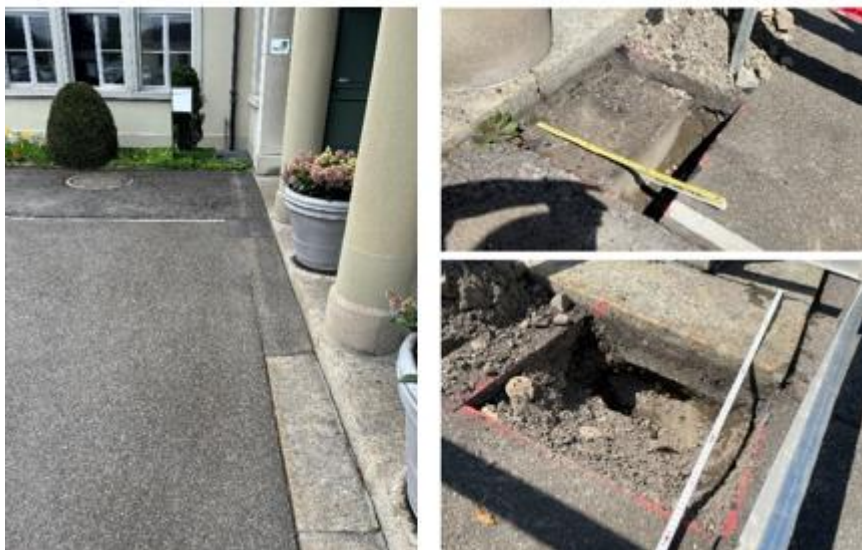
Abb. 8: Aktueller Stand der Gebäudesockel sowie Bilder der Sondagen
