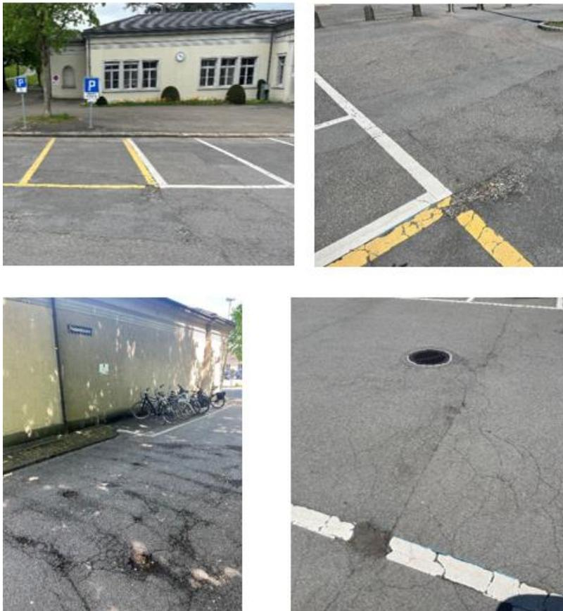
Abb. 2: Aktueller Zustand asphaltierte Fläche Vorzone
