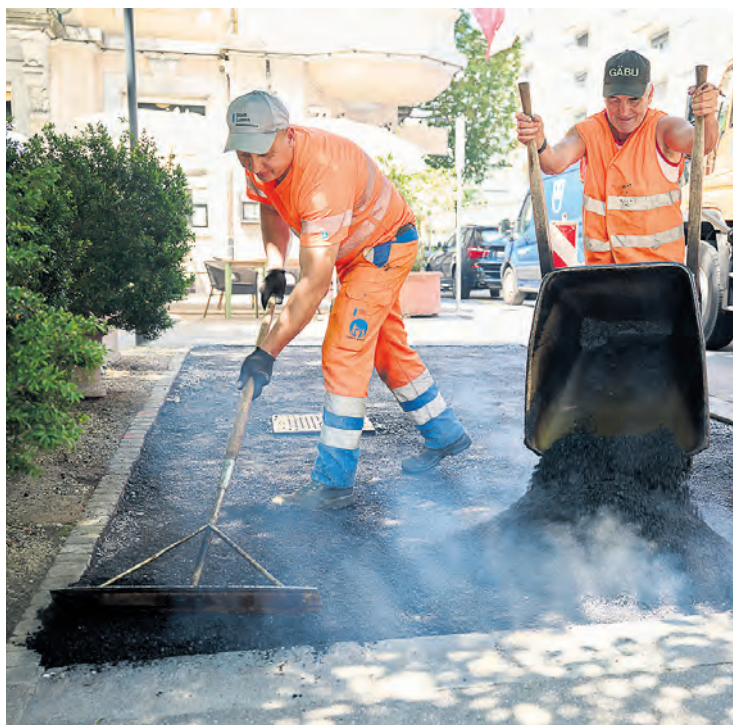
Kleinere Reparaturen und Unterhaltsarbeiten erledigt die Baugruppe.
