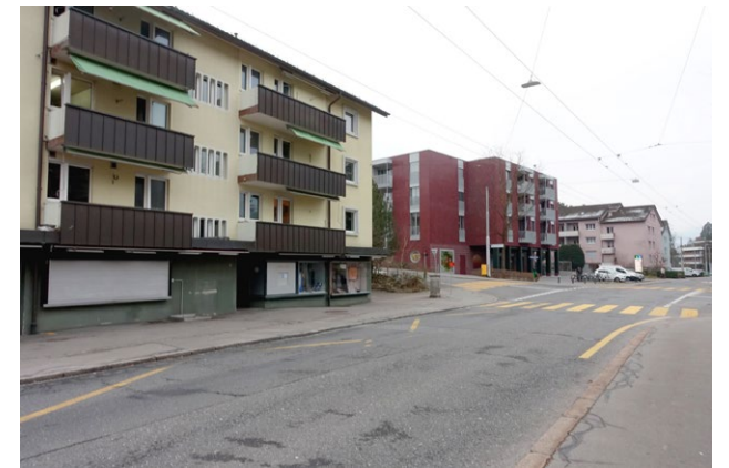
Potential für Erdgeschossnutzung
