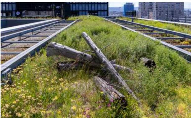
Abbildung 1: Dachbegrünung mit Kleinstrukturen, Letzigraben SBB (ZH)
