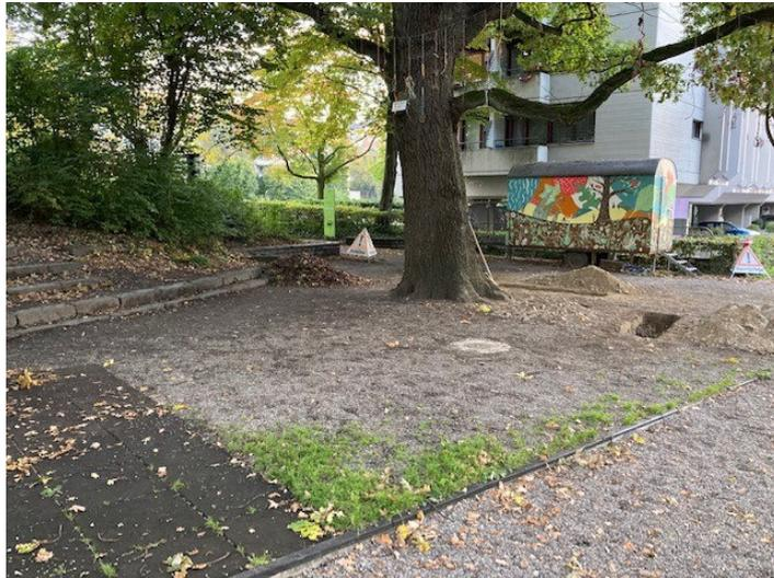
Aufgeschütteter Hügel wird mit Natursteinmauer eingefasst / diverse Abgrabungen zur Erstellung von Fallschutz bei Spielgeräten / der unmittelbare Baubereich ist eingemergelt
