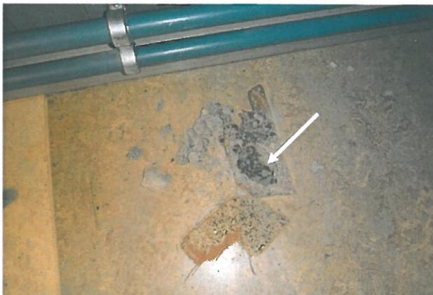
Abb. 33: Pavillon 2: OG, Raum Nr. 16, Bodenfüllung, Spreu
