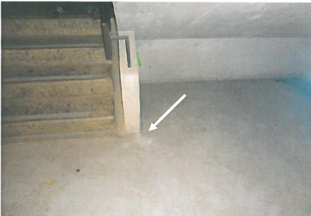
Abb. 27: Pavillon 1: UG, Flur Bodenanstich, grau (Mischprobe mit Bodenanstich SR)
