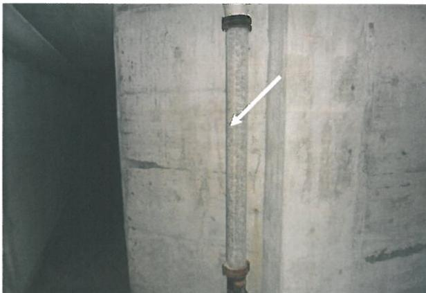
Abb. 3: Pavillon 1: UG, SR/Technikraum, Abwasserrohrre Asbestzement
