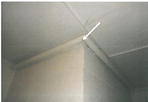
Abb. 17: Pavillon 2: UG, SR/Proberaum, Mörtel Rohrisolierung
