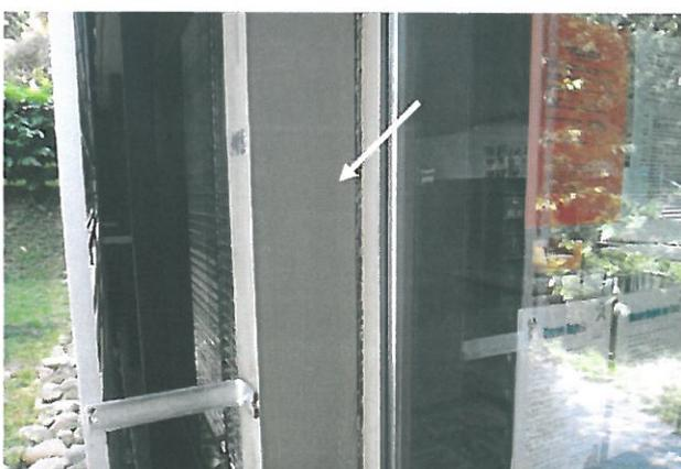
Abb.35: Nebengebäude: EG, Hintereingang, Kitt im Fensteranschluss
