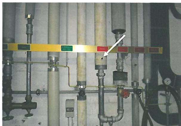
Abb. 12: Nebengebäude, UG, Flur, Mörtel Rohrisolierung Heizungsanlage, weiss
