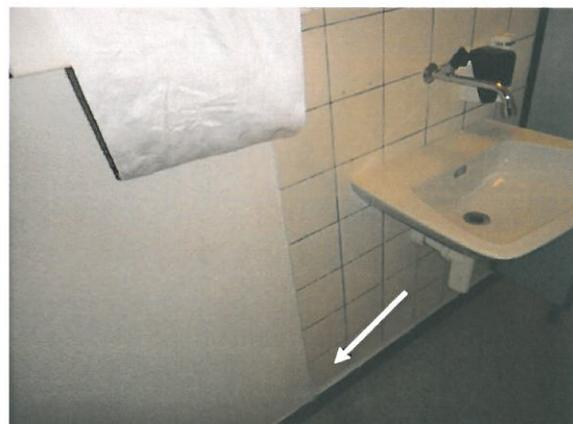
Abb. 18: Pavillon 2: EG, WC, Kleber Keramikwandplatten, weiss, (Mischprobe mit Kleber WC OG)
