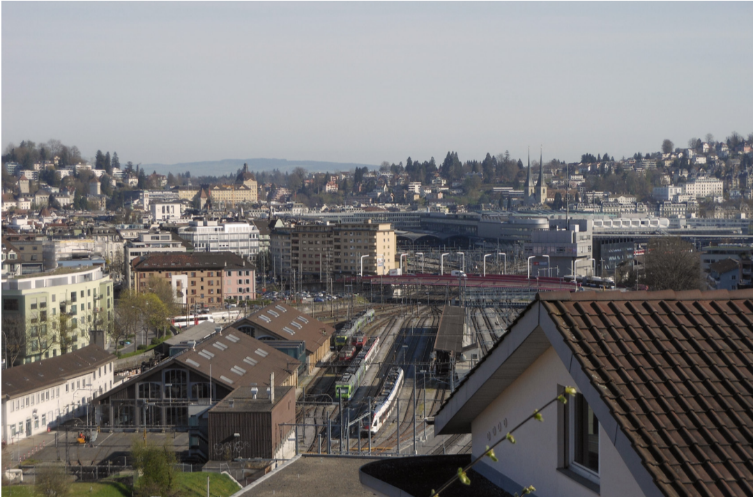
Geleisfeld | Blickrichtung Norden - Langensandbrücke - Bahnhof Luzern - Hofkirche
