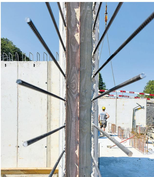
Nicht Kunst am Bau, sondern Armierungseisen für die Betonwand des Eingangsgebäudes.
