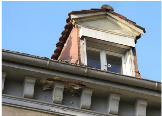
Abb. 2: Feuchteschäden Dachuntersicht
