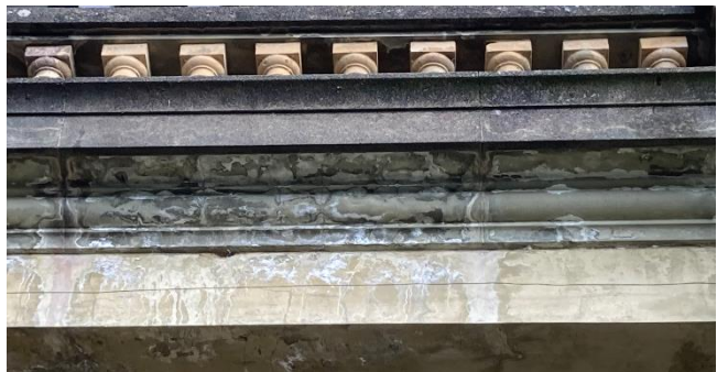
Abb. 6: Feuchteschäden Balkonfries
