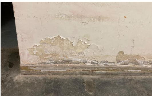
Abb. 5: Feuchteschäden Untergeschoss
