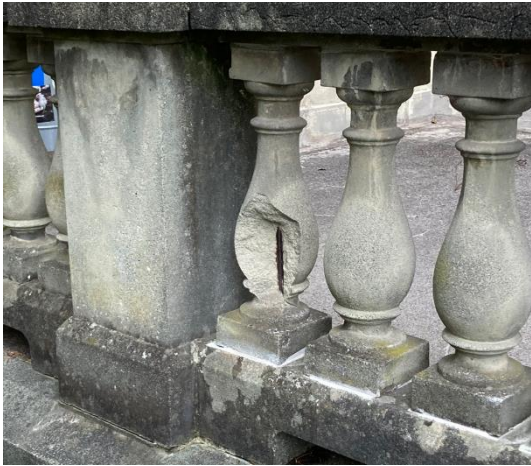
Abb. 1: Abplatzungen Balustrade
