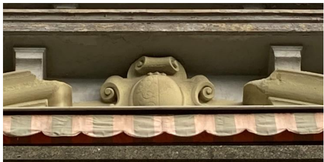
Abb. 4: Sandsteinverwitterung
