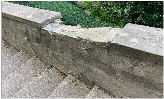
Abb. 8: Beschädigung Mauerkrone
