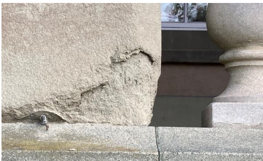
Abb. 3: Abplatzungen Sandstein
