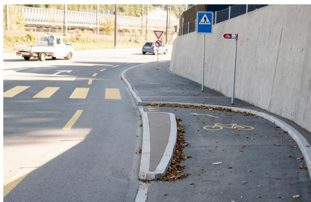
Bei starker Verkehrsbelastung durch den MIV oder einer Doppelspur kann das indirekte Linksabbiegen als Zusatzangebot geprüft werden. Die Anlage auf der Hauptstrasse (Bild) weist bei dieser Querung keine Lichtsignalanlage auf.
