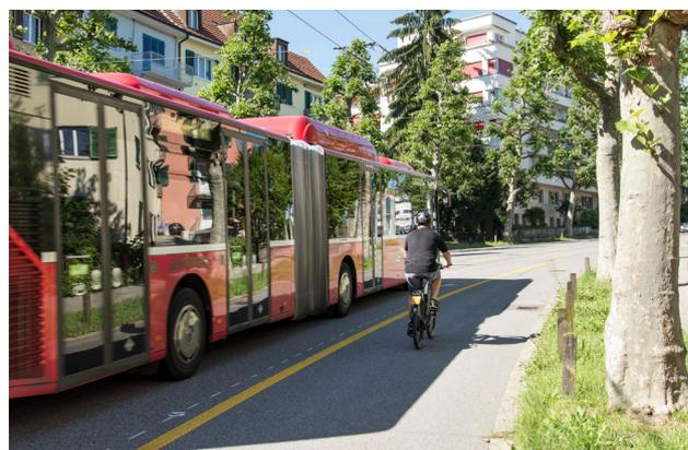
Aufgrund Steigung: Markierung eines Radstreifens anstelle Umweltspur. Damit kann ein gefahrloses Überholen gewährleistet werden.
