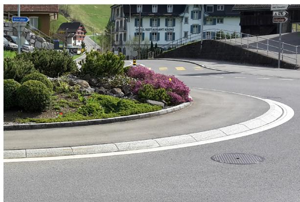
Der aufgeschiftete Innenring ist ein wichtiges Ausführungsdetail. Damit werden ein genügender Ablenkwinkel und in Folge dessen tiefe Geschwindigkeiten des motorisierten Verkehrs sichergestellt. (Bild: Jonas Zurschmiede)
