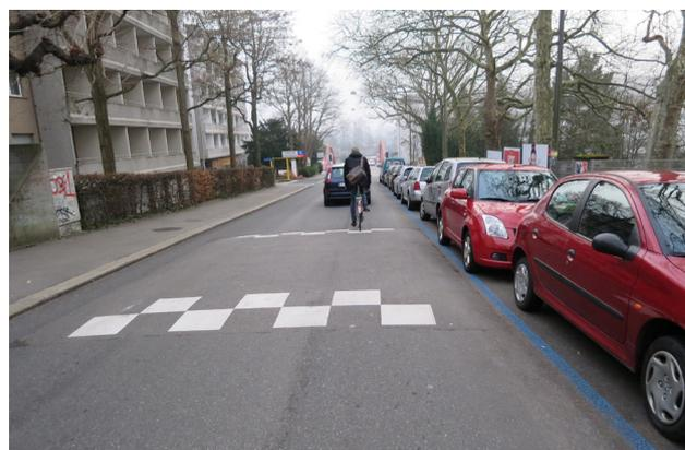
Bühlstrasse, Bern: Der Vertikalversatz ist für Velos bei angemessener Fahrgeschwindigkeit weich genug.
