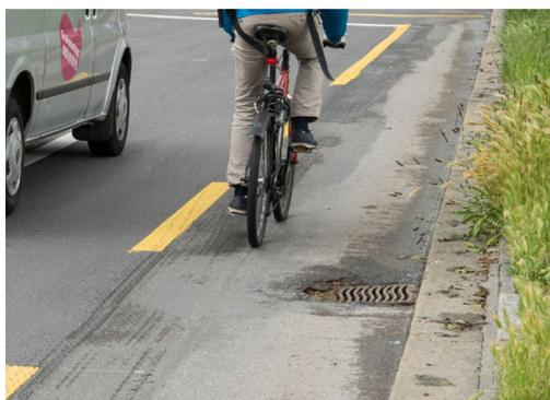
Problematisch: Der Einlauf nimmt vom schmalen Radstreifen eine beträchtliche Breite weg; der Deckbelag ist zudem beschädigt. Dies führt zu Ausweichverhalten und zu Sturzgefahr.
