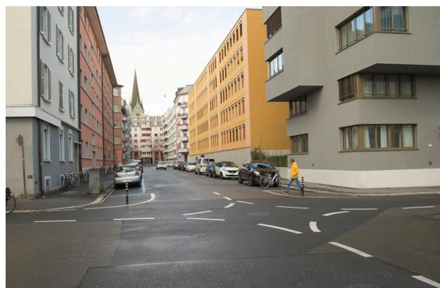
Kleine Radien, in diesem Fall markiert, tragen zur Reduktion der Querungsdistanz bei wunschliniengerechter Querung bei. Zudem kann damit die Geschwindigkeit gedrosselt werden. (Kleinhattstrasse/Bleicherstrasse, Luzern)
