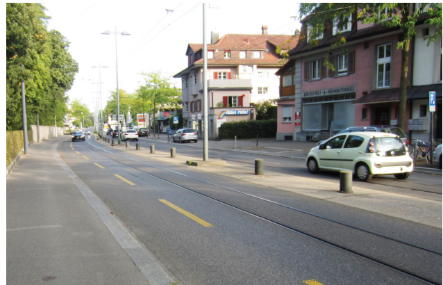
Mehrzweckstreifen in baulicher Ausführung; hier optimiert als Querungshilfe für Fussverkehr; Befahrbarkeit aufgrund Pollern nur für Zweiräder. Seftigenstrasse in Wabern.
