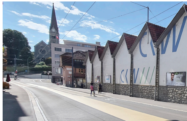
Hauptstrasse, Luzern: Mehrzweckstreifen ausgeführt mit FGSO. (Bildquelle: Tiefbauamt Stadt Luzern)
