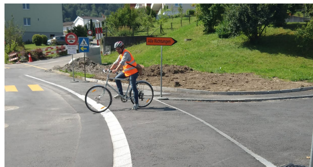
Ritterstrasse, Luzern: Neue Randsteinlösung für Luzern. 6 cm schräg mit einem 25-Stein. (Bildquelle: Tiefbauamt Stadt Luzern)
