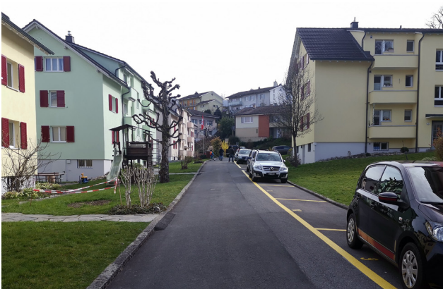
Haselweg, Luzern: Strasse ohne Fussweg mit seitlichen Längsparkfeldern im Wohnquartier
