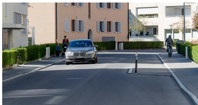
Dorfstrasse, Luzern; bauliche Einengung
