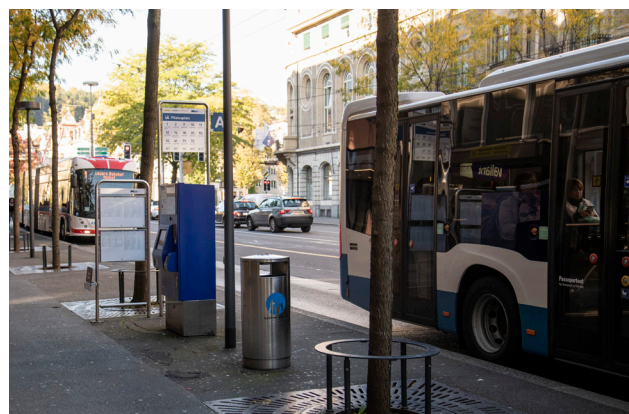
Haltestelle Pilatusplatz, Luzern; Haltestellenausrüstung ungenügend. Keine behindertengerechte Sitzgelegenheit, fehlende oder zu weit entfernte Überdachung bei schlechtem Wetter und diverse Hindernisse im Ein- und Ausstiegsbereich.
