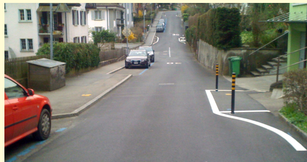
Markierte Einengung mit markierten Füssen; Bergstrasse, Luzern. (Bildquelle: Tiefbauamt Stadt Luzern)
