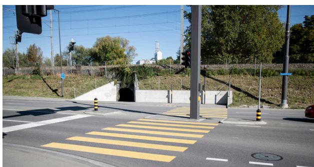
Reussbühlstrasse, Luzern; Lichtsignalanlage nach Tiefbau Norm Luzern.
