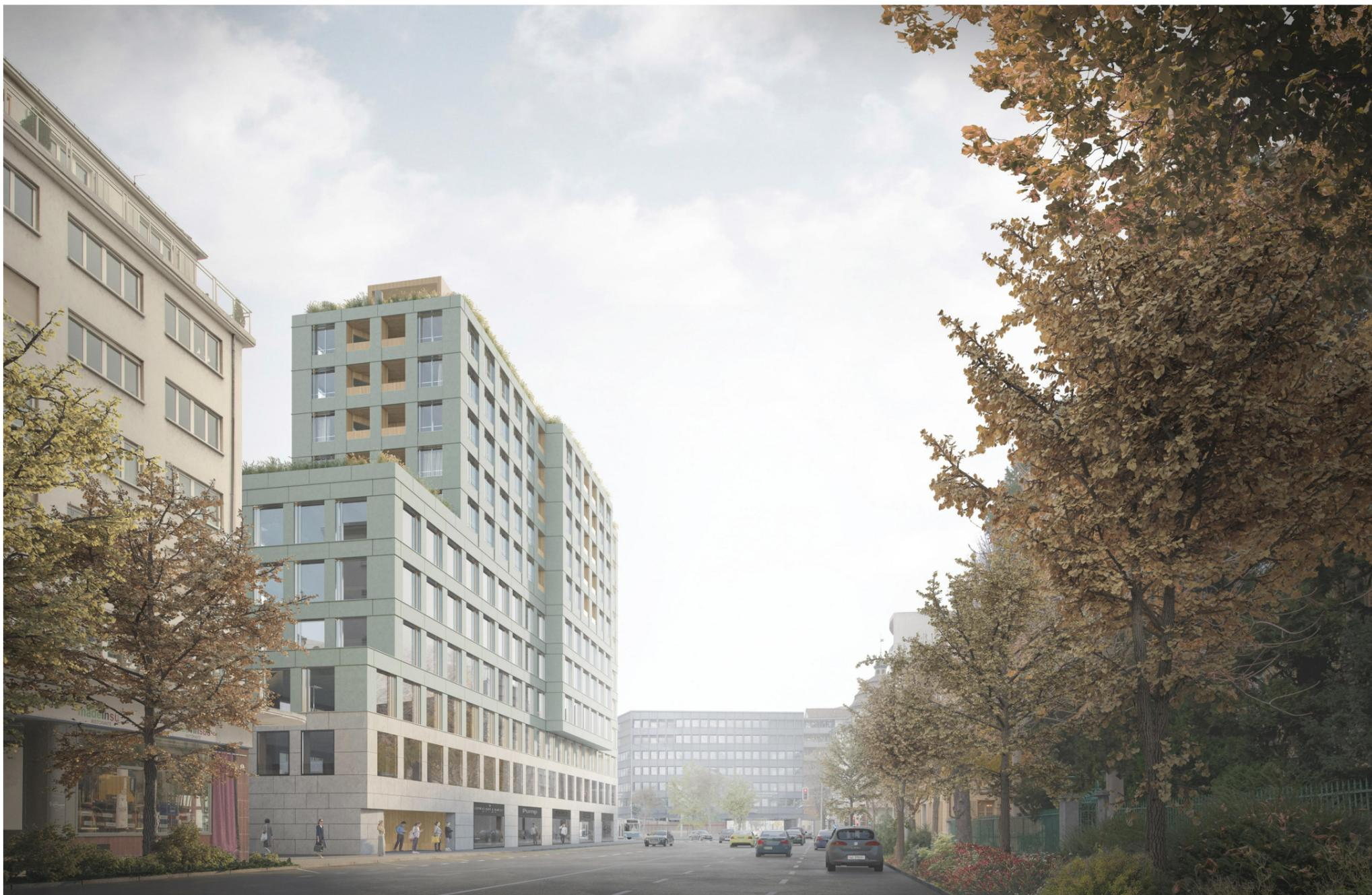
Der Sockel wird mit weissem Kalkstein verkleidet, er stellt eine Bereicherung der Architektur auf Strassenebene dar, im südlichen Abschluss bildet dieser eine Nische zur Aufnahme der Bushaltestelle.
