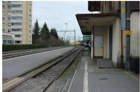
Blick aus Richtung Westen, SBB-Perron und alter Güterschuppen
