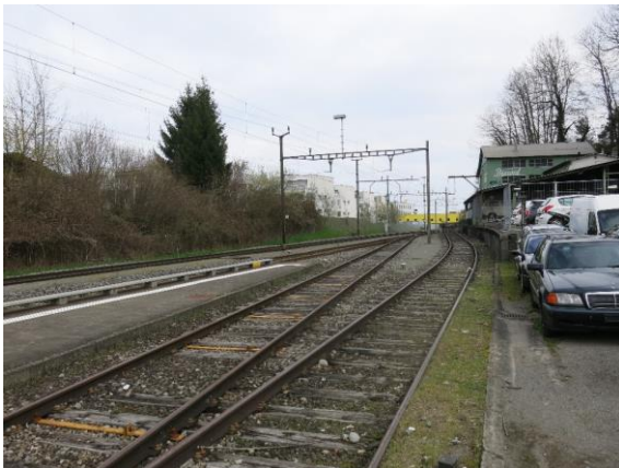
Blick auf hinteren Abschnitt SBB-Perron mit Gütergleis in Richtung Westen
