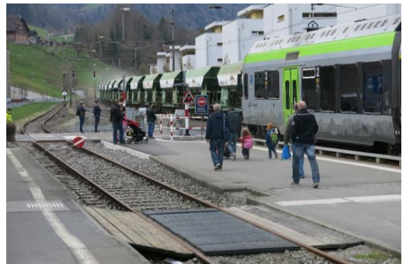
SBB-Perron mit Niveauübergang Südseite
